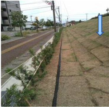
写真-4 法面施工直後
