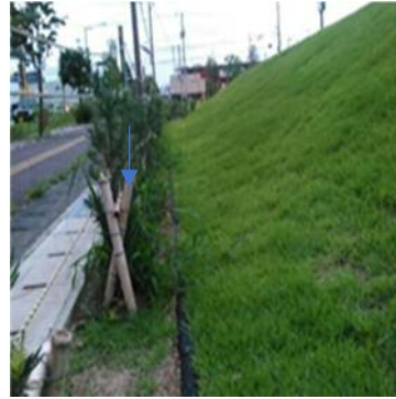
写真-5 法面施工約3ヶ月後
