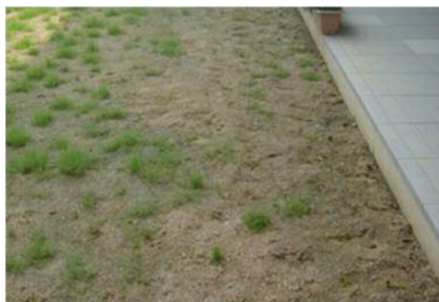
写真-1 排水不良による育成障害
