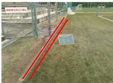
写真-6 人工芝グラウンドへの施工例
