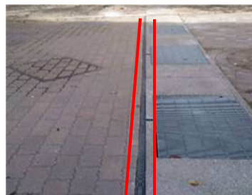
写真-7 インターロッキング舗装道への施工例
