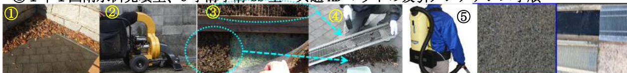
↑写真-5 ①グレーチング上及び周辺のゴミ②バキューム吸引清掃③グレーチングに挟まったゴミとHDマットとの間に堆積したゴミの取り残し分④ゴムハンマー等で取り除く⑤HDマット個別吸引後戻す。
