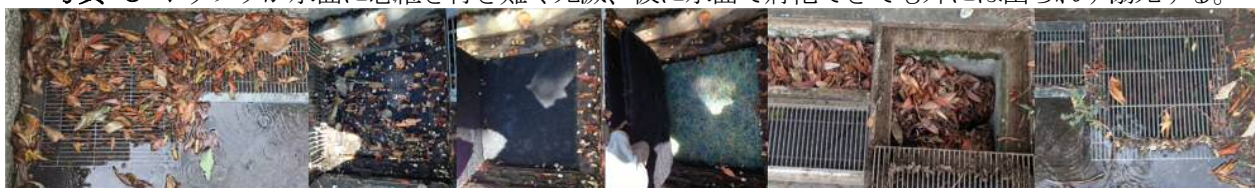
写真-4 新技術ではHDマットで極細分別を施し蚊の成虫や落ち葉が遮断される。
