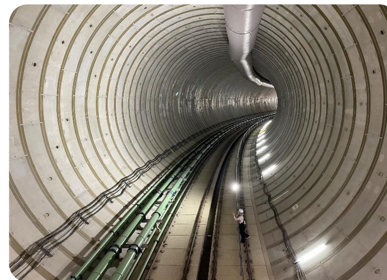
トンネル施工中
