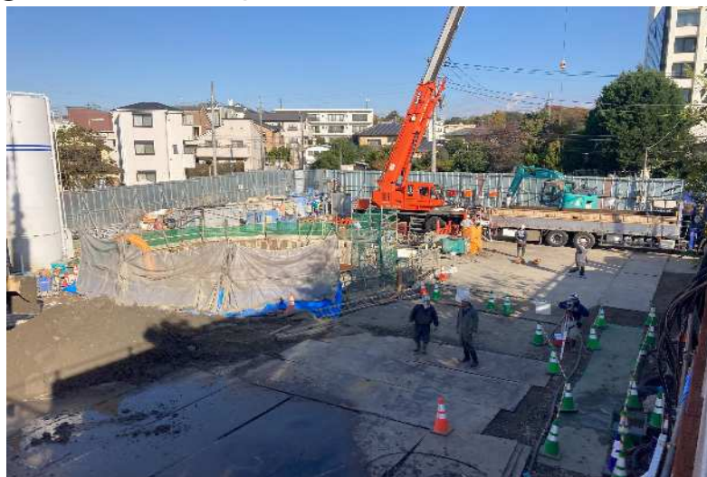
④方向より撮影(全景:北向き)
