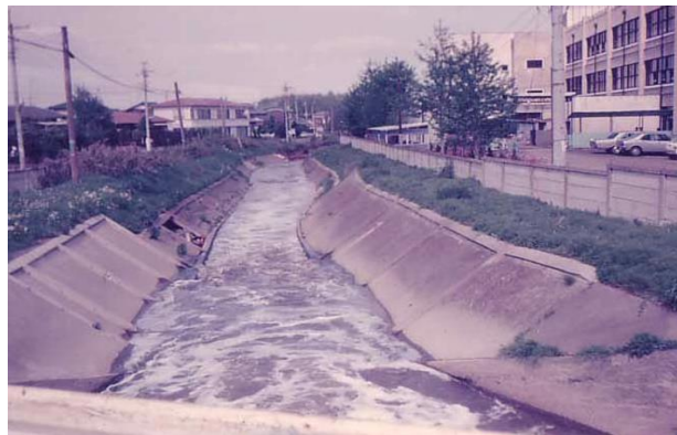
写真 2-7 汚濁が著しい頃の空堀川(昭和 50 年代)
