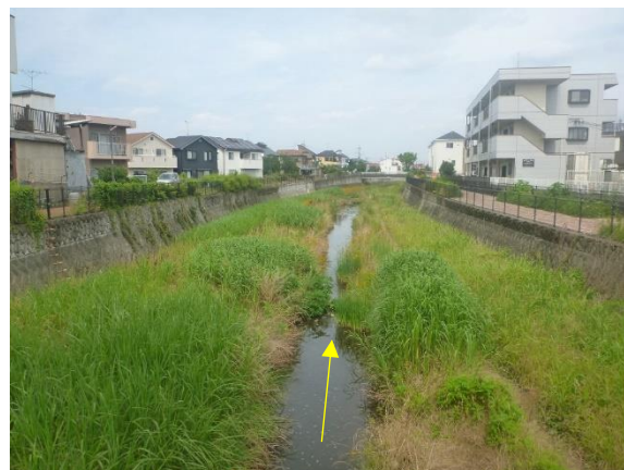
写真 2-3 護岸の整備状況（東大和市奈良橋）
