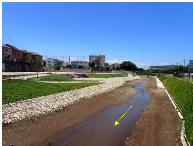
写真 2-10 緩傾斜護岸の整備状況（中砂の川橋上流）
