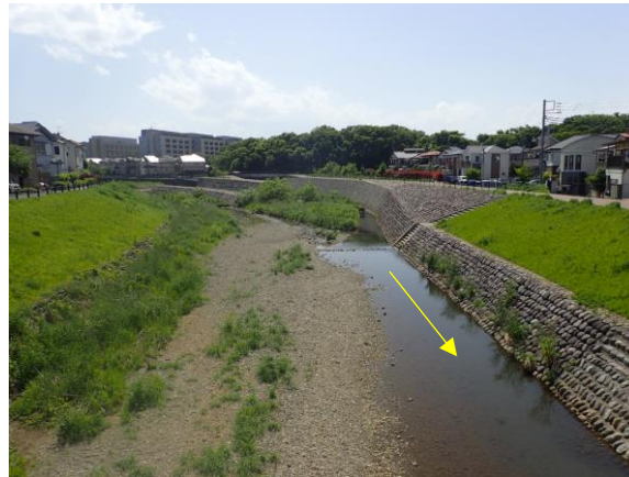
写真 2-2 護岸の整備状況（清瀬市中里）
