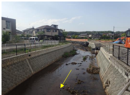
写真 2-4 護岸の整備状況（東大和市高木）
