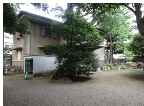
写真 4：倉庫周辺の状況 令和 6 年（2024）10 月
