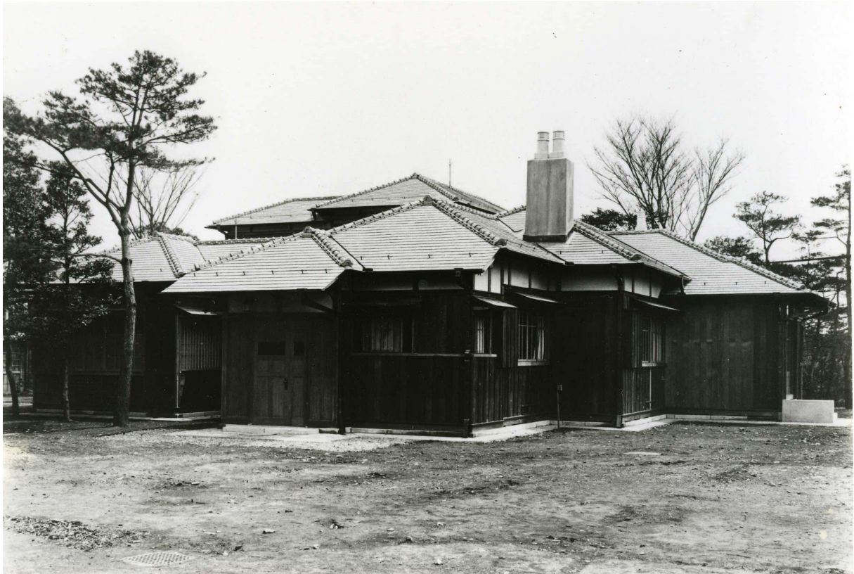
写真 30 : 竣工時の主屋（南西側より撮影）（昭和9（1934）年頃） 東京都公園協会（東京グリーンアーカイブス）所蔵
