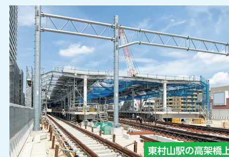
東村山駅の高架橋上
