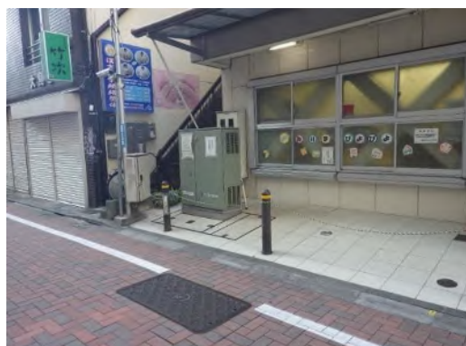
図 4-11 公共用地等への地上機器設置事例
