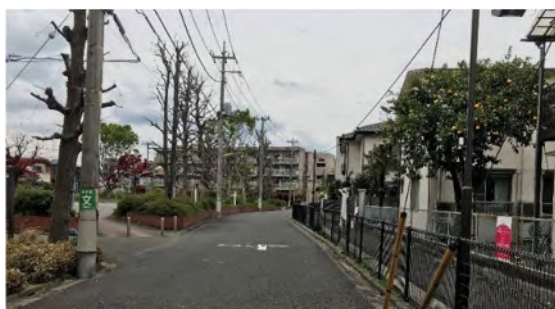
図 13-9 都営住宅敷地内にある電柱の事例
