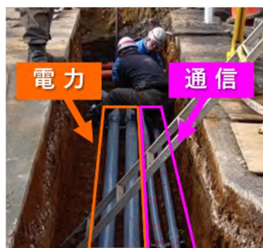
図 10-7 同時施工の取組状況
