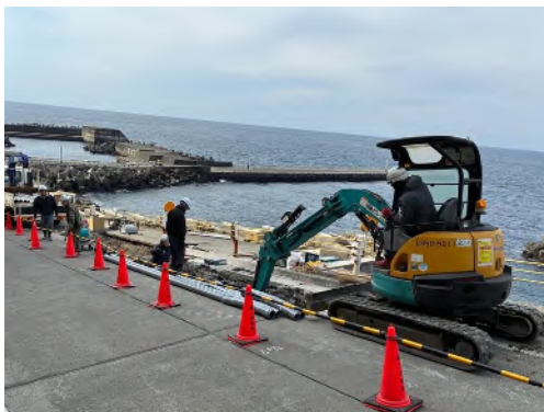
図 9-3 御蔵島内の施工状況
