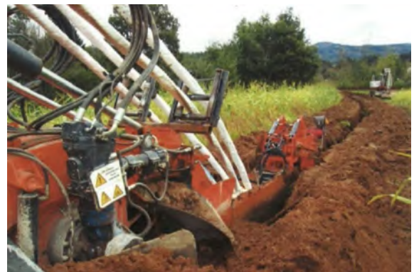
専用機材による施工状況
