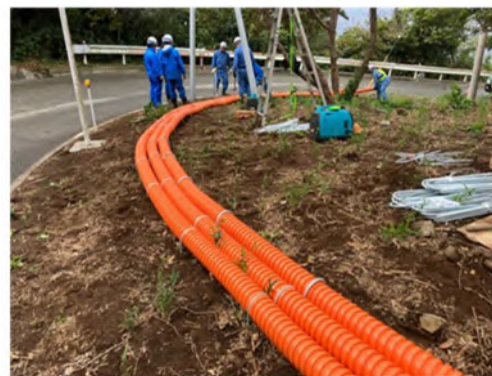
図 9-4 利島内の試験施工状況
