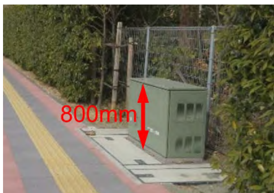
図 11-6 地上機器のコンパクト化 （出典：無電柱化推進のあり方検討委員会資料 （令和8年4月 国土交通省））
