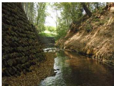
城山川 出羽橋上流
