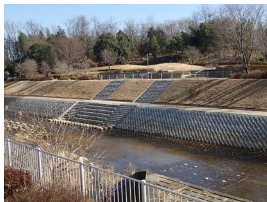
大栗川 緑化工事状況（番場橋上流）
