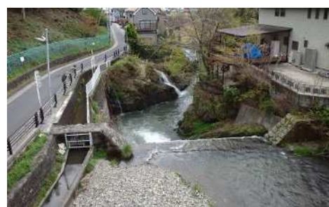
南浅川 白山橋下流
