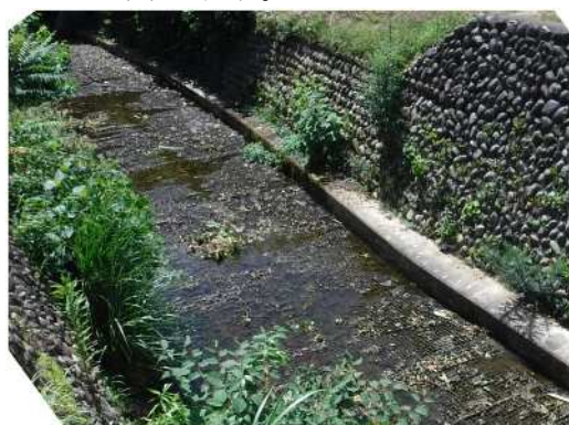
河床低下の保護措置 対策前後 (谷地川 コスモス橋付近)
