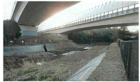
流下断面の確保（河床掘削）対策前後 （川口川 十内入橋付近）
