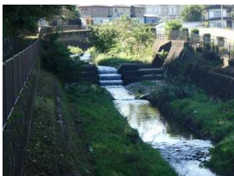
城山川 不動橋上流
