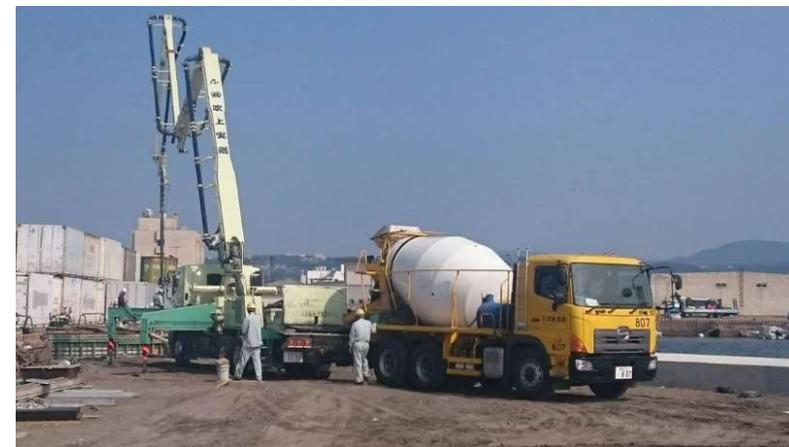
コンクリートミキサー車・コンクリート圧送ポンプ車
