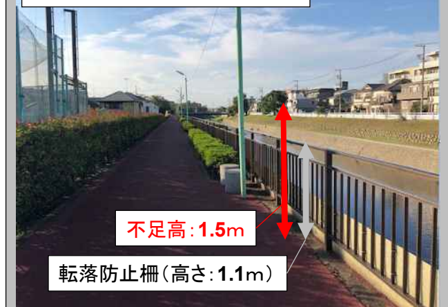
野川水道橋下流右岸(整備前)
