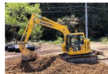
バックホウ (構造物撤去工)
