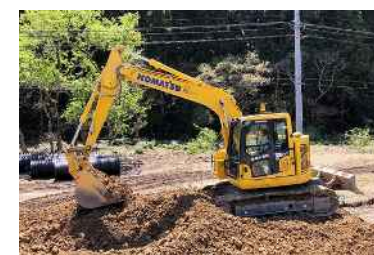
バックホウ (仮設工、河川土工)
