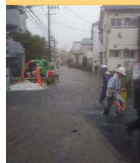
③諏訪排水樋管付近
