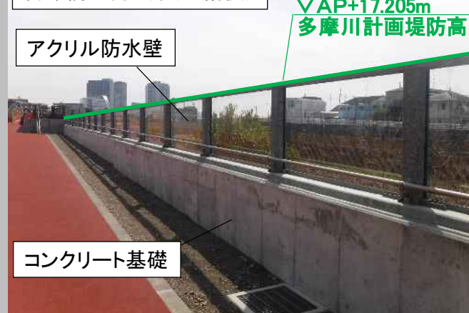
吉澤橋下流左岸(整備後)
