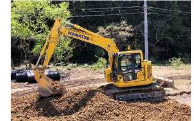
バックホウ (構造物撤去工)
