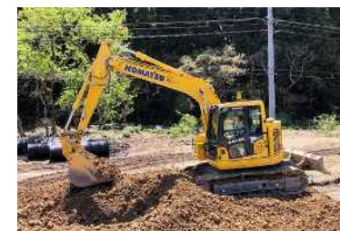
バックホウ (仮設工、河川土工)
