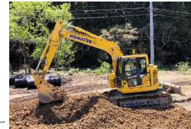
バックホウ (構造物撤去工)
