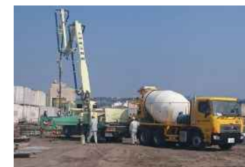
コンクリート圧送ポンプ車 (L型擁壁工)
