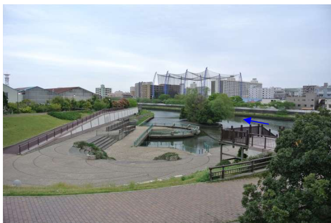
写真 2-7 新河岸川の旧河道のワンドに整備された舟渡水辺公園 (板橋区舟渡四丁目付近)
