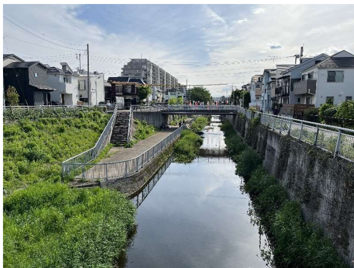
写真 2-11 親水整備された護岸（練馬区東大泉二丁目付近）
