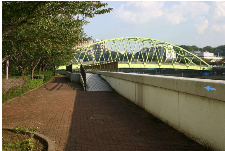
写真 4-2 管理用通路の嵩上げ、緑化、遊歩道整備の状況 (新河岸大橋上流左岸。北区浮間五丁目付近)
