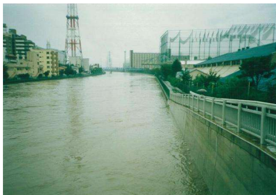
写真 2-1 新河岸川西台橋付近の増水 (平成3年9月19日台風18号)
