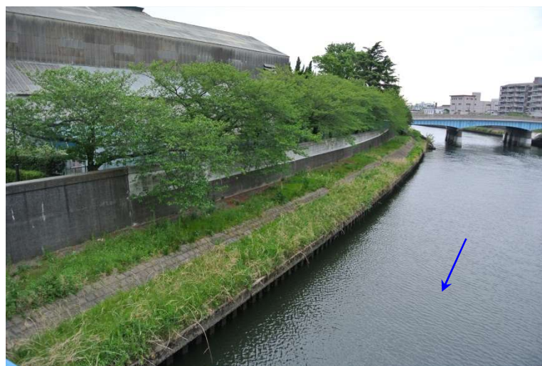
写真 4-1 高水敷の現況（平成橋下流。板橋区東坂下二丁目付近）
