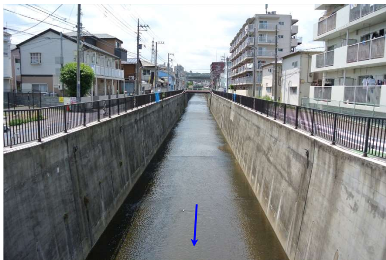
写真 4-6 大成橋上流（板橋区成増三丁目付近） 東埼橋まで落差工が続く。
