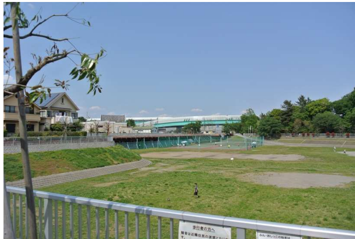
写真 2-9 比丘尼橋上流調節池に設置された練馬区立びくに公園 (練馬区東大泉二丁目付近)
