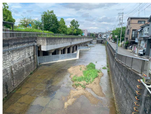
写真 2-4 比丘尼橋下流調節池 流入口
