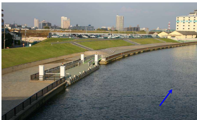
写真 4-3 浮間橋下流左岸の防災船着場、緩傾斜護岸、親水テラス整備状況 (北区浮間一丁目付近)
