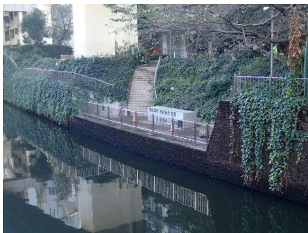
写真 2-6 古川（新広尾公園）整備状況
