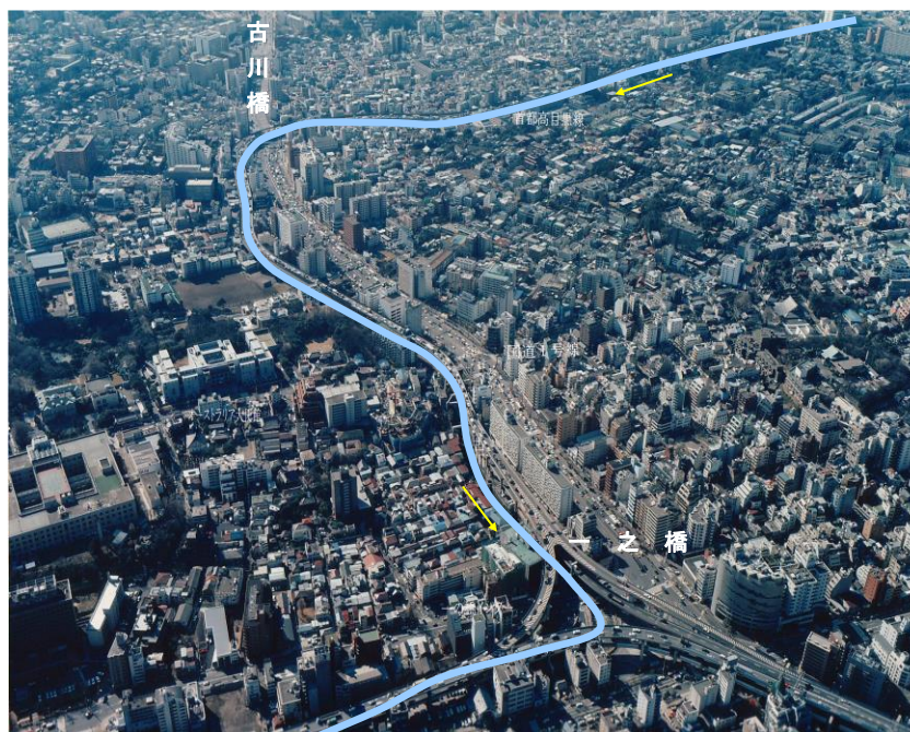
写真 1 - 1 古川（古川橋～一之橋付近）空中写真
