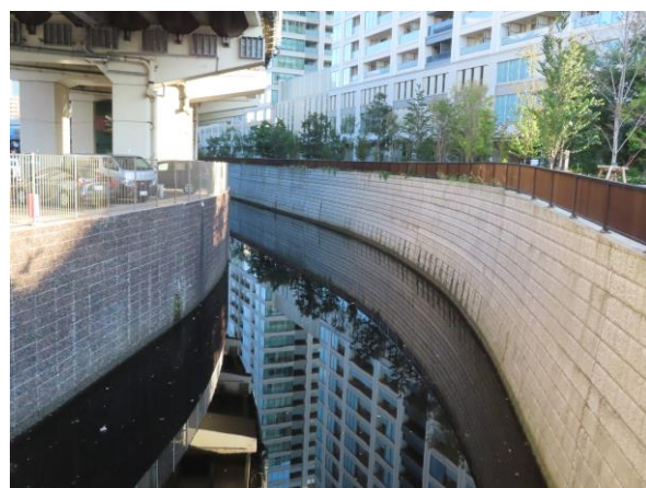
写真 2-5 古川（新古川橋下流）整備状況
