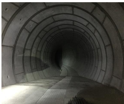
写真 2-7 古川地下調節池内部
