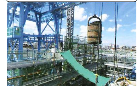
掘削した土砂搬出の様子
