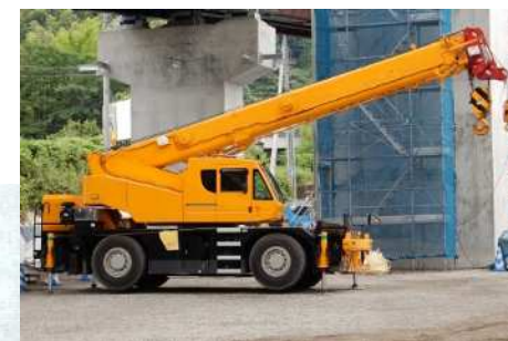
組立用クレーン
