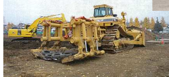
重機組立エリア
