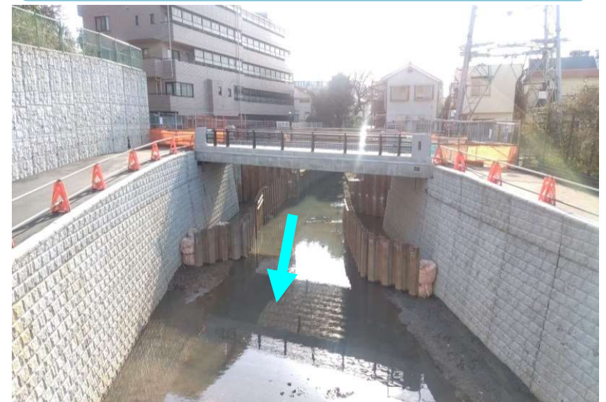
下流側から曙橋を眺めた視点
