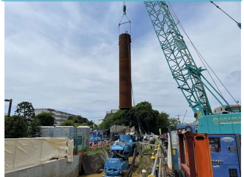
鋼管杭打設の様子
