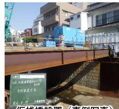
仮栈橋設置 (事例写真)
