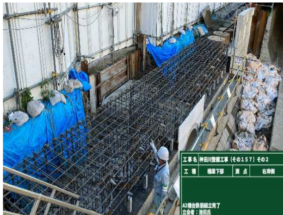
橋台施工 (事例写真)
