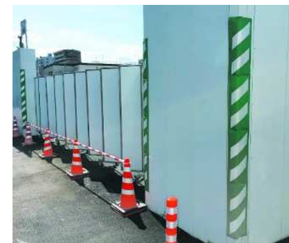
搬出入ゲート参考写真
