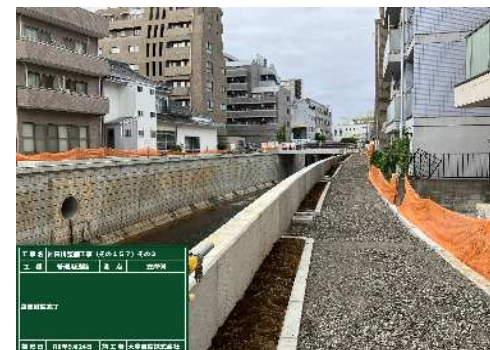
管理用通路仮舗装完了 (事例写真)
