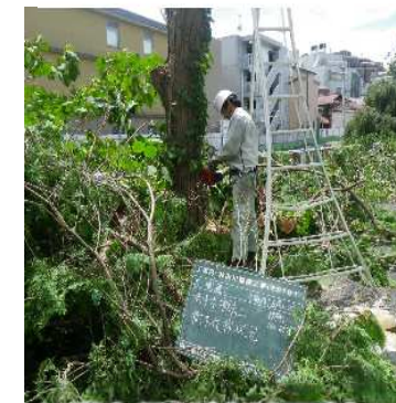
樹木伐採(事例写真)
