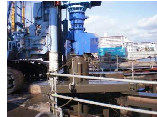
鋼管杭打込 (事例写真)
