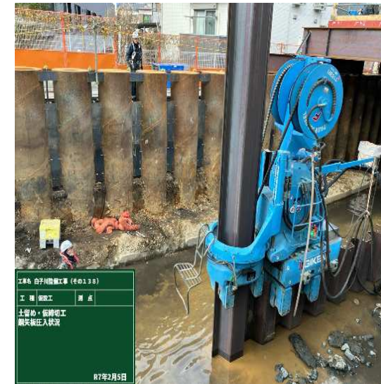
鋼矢板圧入 (事例写真)
