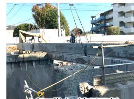
上部工撤去 (事例写真)
