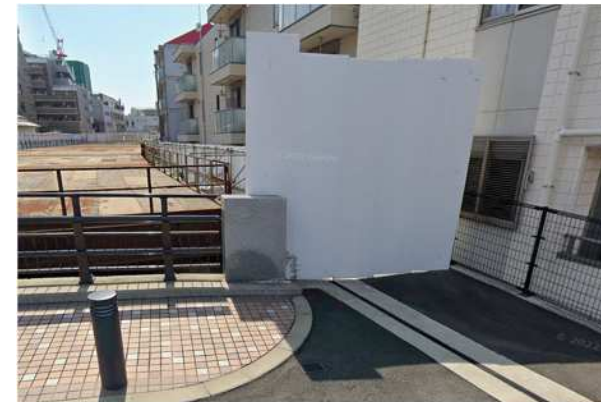
施工完了後管理用通路閉鎖（事例写真）
