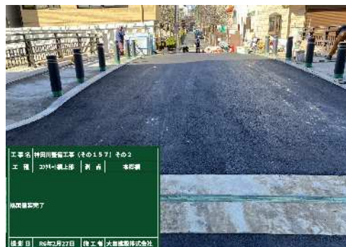
橋面舗装完了 (事例写真)
