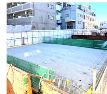
橋架設完了（事例写真）
