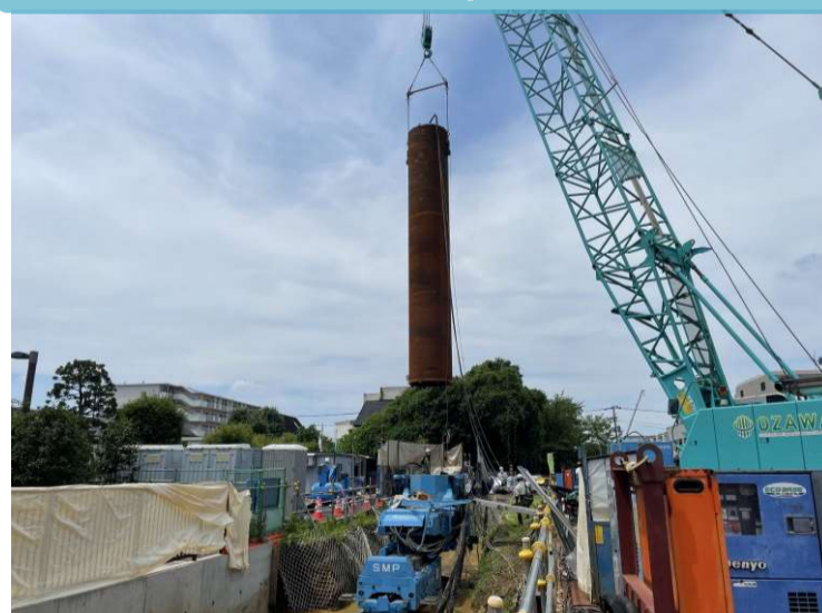
鋼管杭打設の様子
