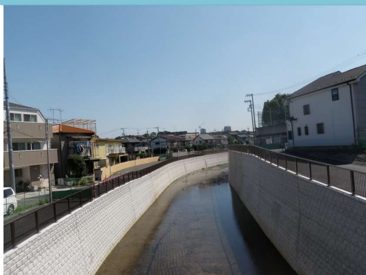
（既整備済み 愛宕橋下流）
