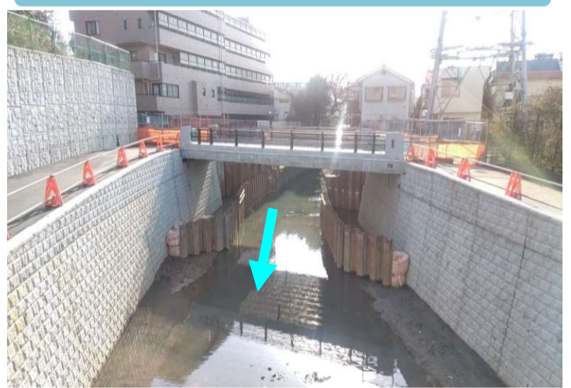
下流側から曙橋を眺めた視点
