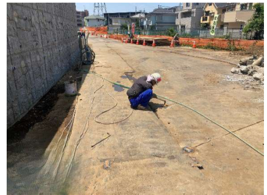
鉄板溶接状況 (前回工事)
