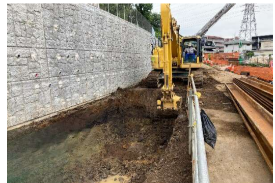
1次掘削（前回工事）
