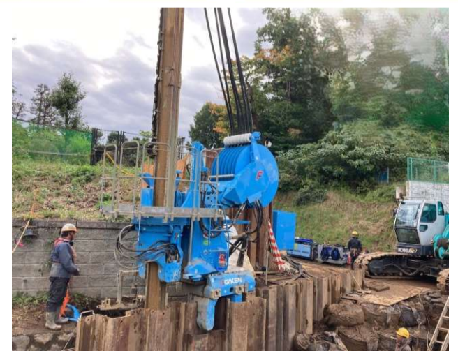
鋼矢板施工状況 (前回工事)
