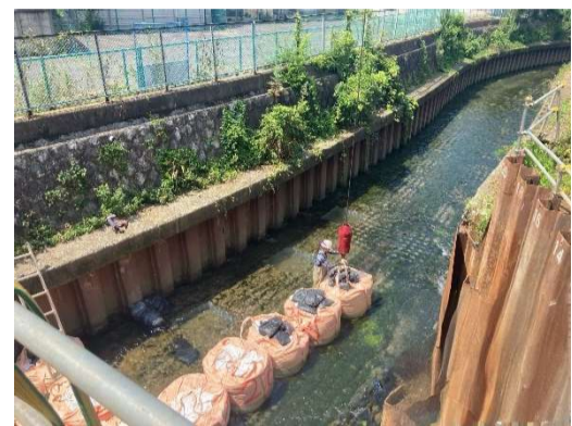
河床版大型土のう設置状況 (前回工事)
