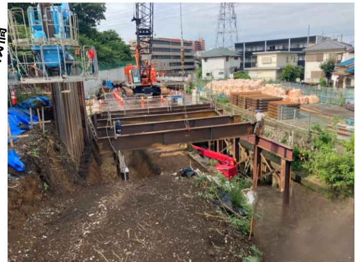
仮棧橋施工状況 (前回工事)
