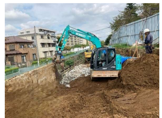
取壊し状況（前回工事）
