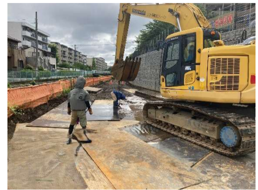
鉄板敷設状況 (前回工事)
