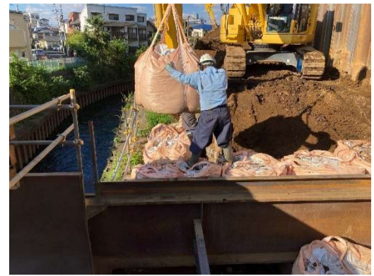
大型土のう設置状況 (前回工事)
