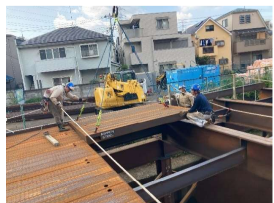
仮栈橋施工状況 (前回工事)
