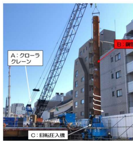
施工参考写真
