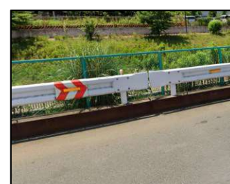
置きガードレール
