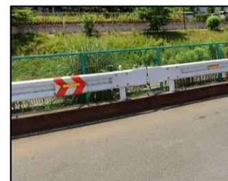
置きガードレール
