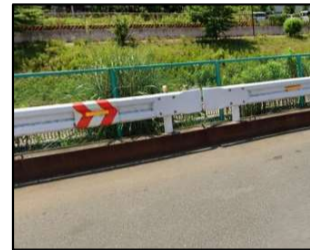
置きガードレール
