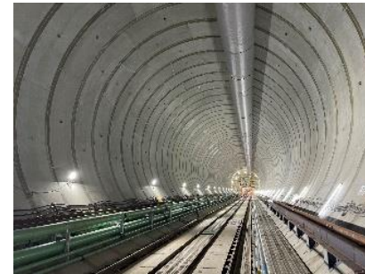
②環状七号線地下広域調節池 (練馬区・中野区) 規模：約681,000m 3 ※既存とあわせて約1,430,000m 3
