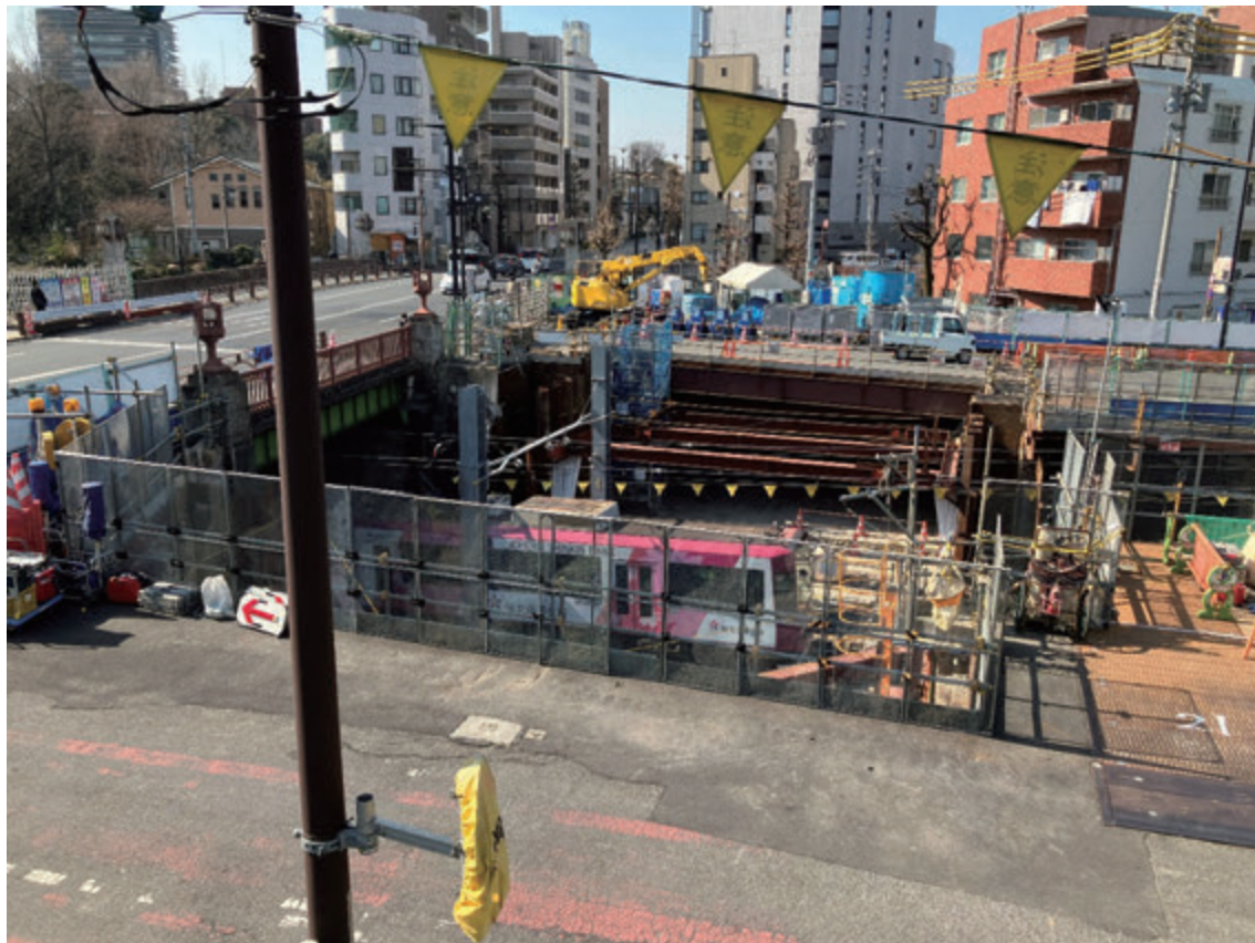
環状第5の1号線（雑司ヶ谷）整備 （豊島区高田三丁目～南池袋二丁目） ～雑司が谷環状第5の1号線トンネル(仮称)発進立坑の築造状況～
