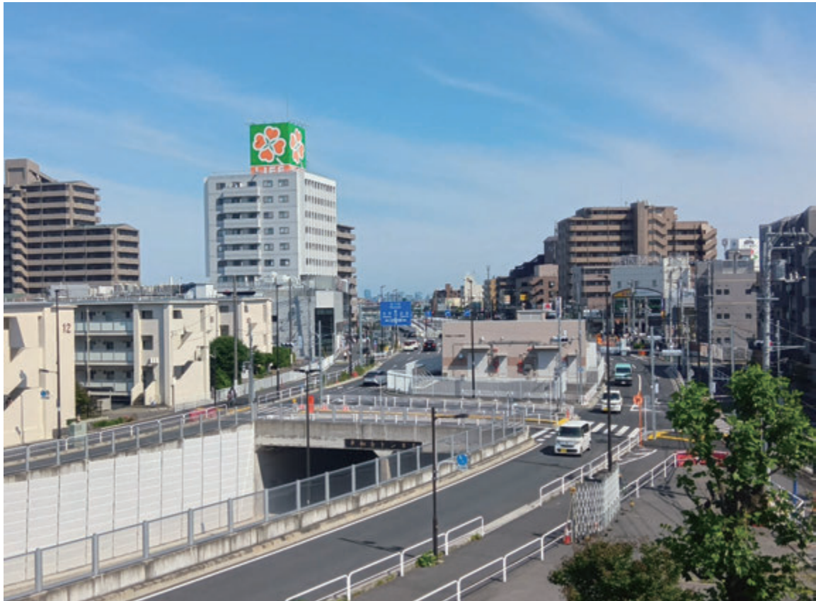
放射第35号線（早宮・北町）整備 （練馬区早宮二丁目～北町五丁目） ～平和台トンネル電気室及び街築工事整備状況～
