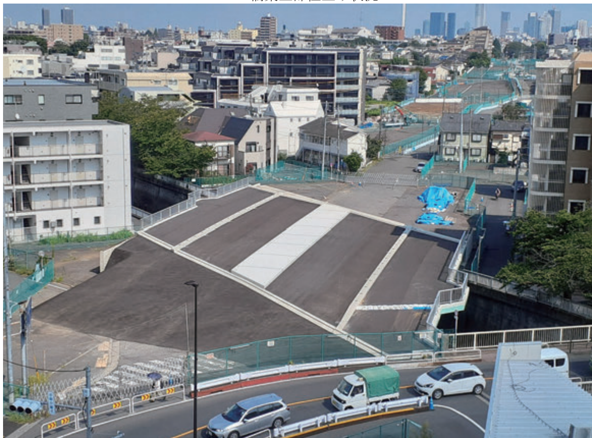
放射第36号線（氷川台橋梁）整備 （練馬区桜台三丁目～氷川三丁目） ～橋梁上部仕上げ状況～
