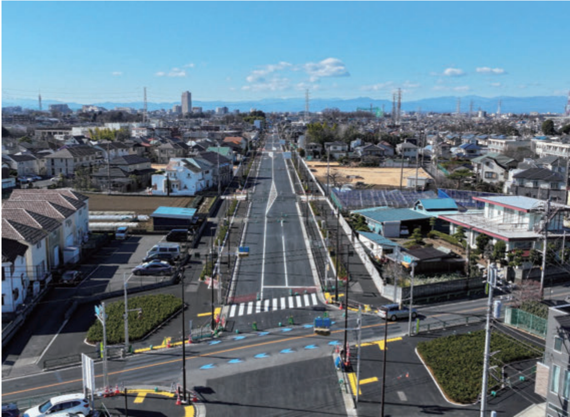
放射第7号線（大泉）整備 （練馬区大泉学園町二丁目～西大泉五丁目） ～西側区間 暫定交通開放(令和7年2月16日)～
