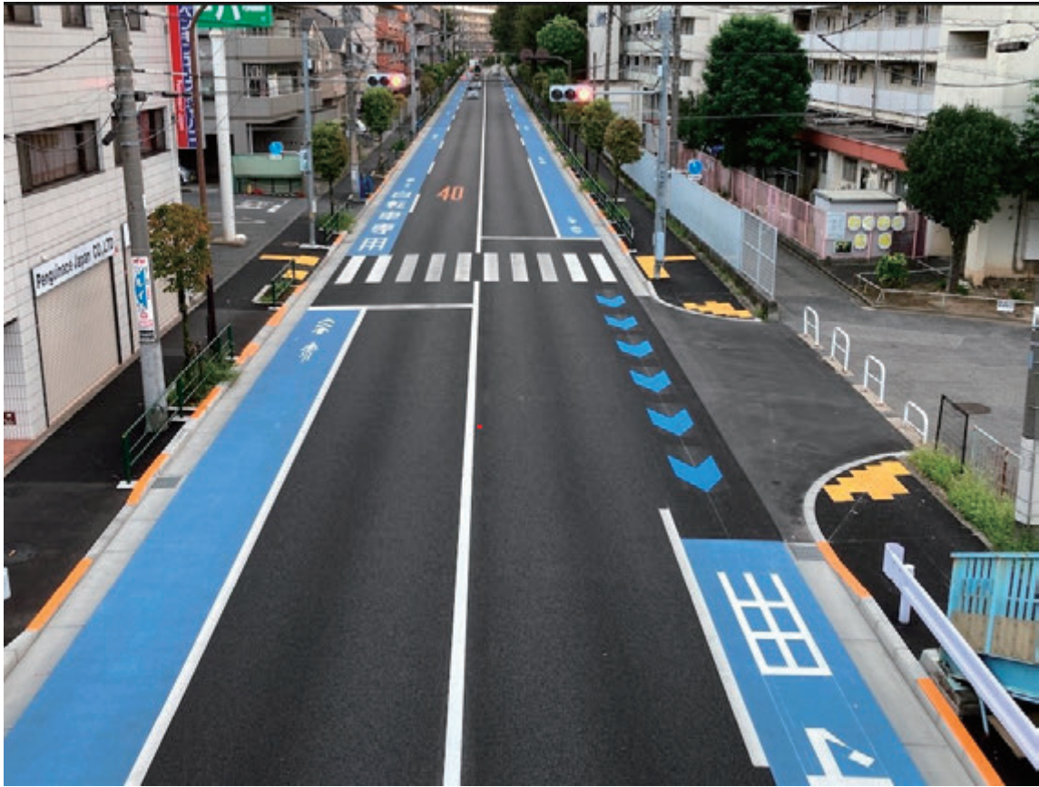
低騒音舗装及び自転車レーンの設置 一般都道杉並田無線（第245号）新青梅街道 （練馬区石神井台四丁目付近）
