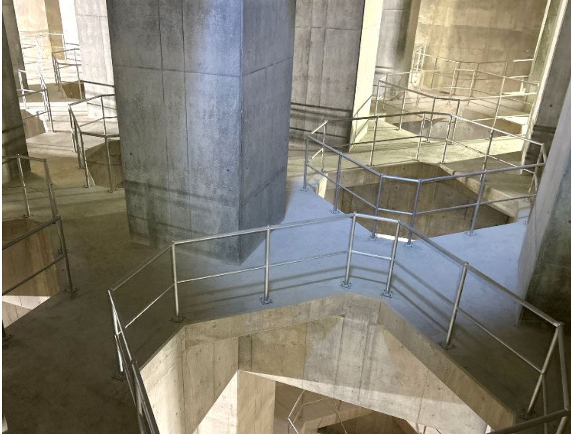
城北中央公園調節池（一期）工事整備 （板橋区小茂根五丁目、練馬区羽沢三丁目付近） ～調節池内の内部構築状況～
