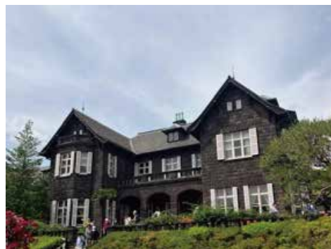
<洋館外壁の修理>
