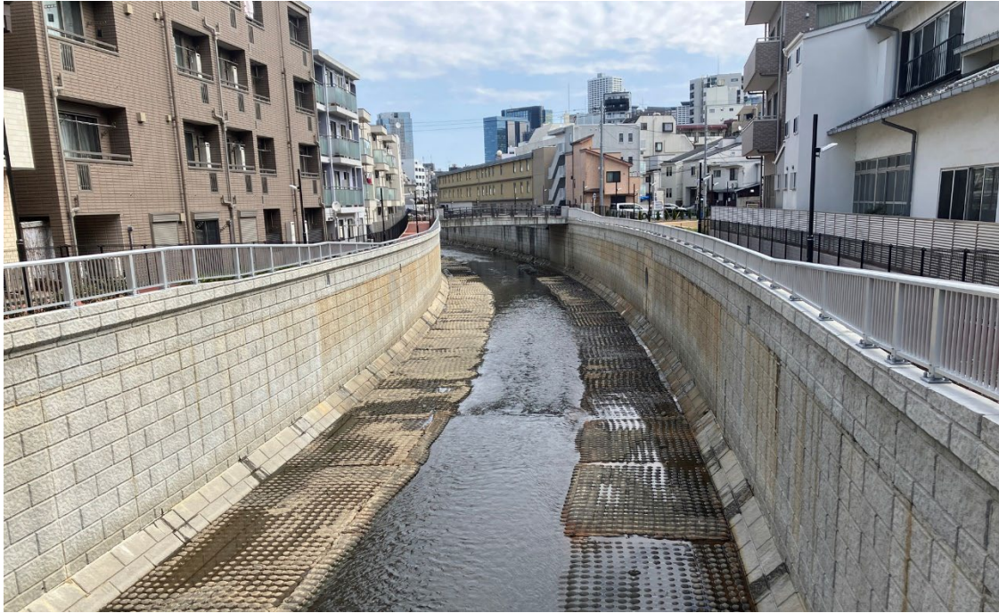
神田川整備工事(新橋～寿橋区間)〔中野区本町五丁目～同区弥生町二丁目〕 下流から護岸の整備を進め、新橋、氷川橋、千代田橋、柳橋の架け替えを行い、本郷橋の下流まで完了しました。工事は狭隘な現場状況から河川の上部を全面覆工して実施しました。
