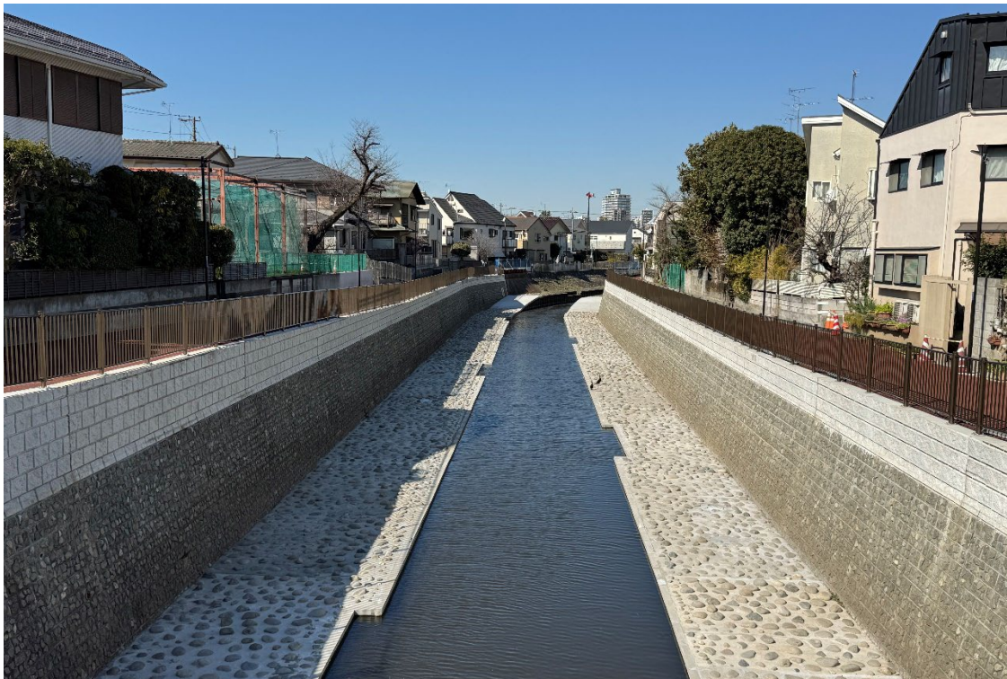
善福寺川整備工事(神通橋～松溪橋)〔杉並区成田西四丁目から同区荻窪二丁目地内〕 平成28年に善福寺川調節池が取水開始したため、上流の神通橋から松溪橋までの区間の整備に着手しました。令和6年度には神通橋の架け替え及び上流の護岸整備、西田端橋上流から大谷戸橋下流の護岸の鋼管及び仮設構台の設置が完了しました。
