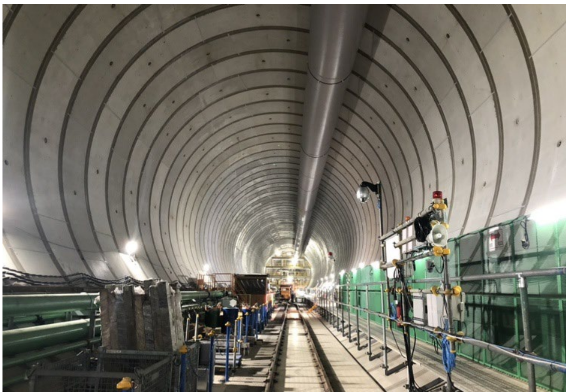
環状七号線地下広域調節池(石神井川区間)工事〔中野区野方から練馬区高松地内〕 妙正寺川立坑からシールドマシンが発進し、環状七号線の地下でトンネル掘進を進めています。
