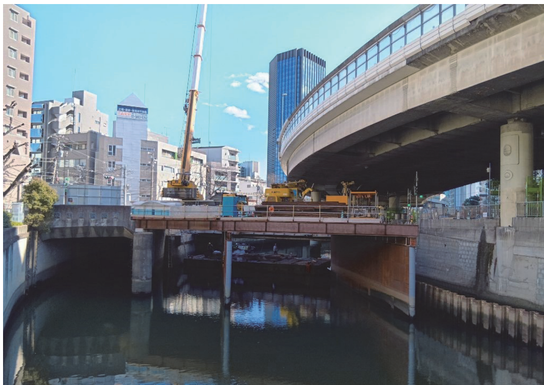
中小河川整備事業工事 文京区後楽二丁目～新宿区新小川町付近 ～洪水に対する安全性の向上のため、神田川で護岸整備工事を実施中～
