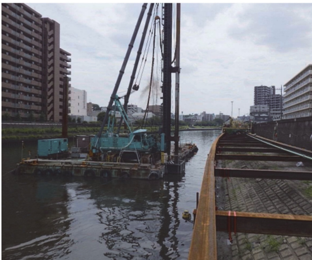
東部低地帯の耐震対策事業 北区浮間三丁目付近 ～地震に対する安全性の向上のため、新河岸川で耐震対策工事を実施中～
