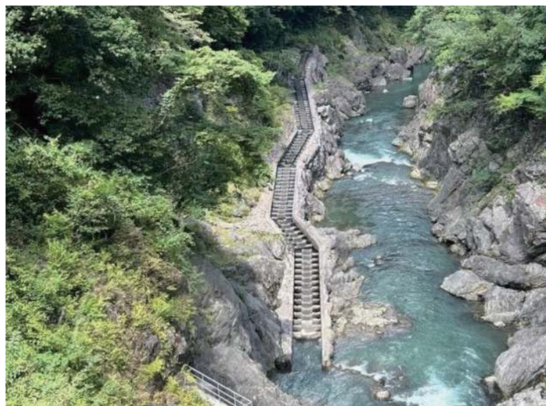
白丸ダム魚道
