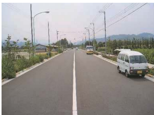
あきる野市： 幅員18mで完成した都道伊奈福生線
