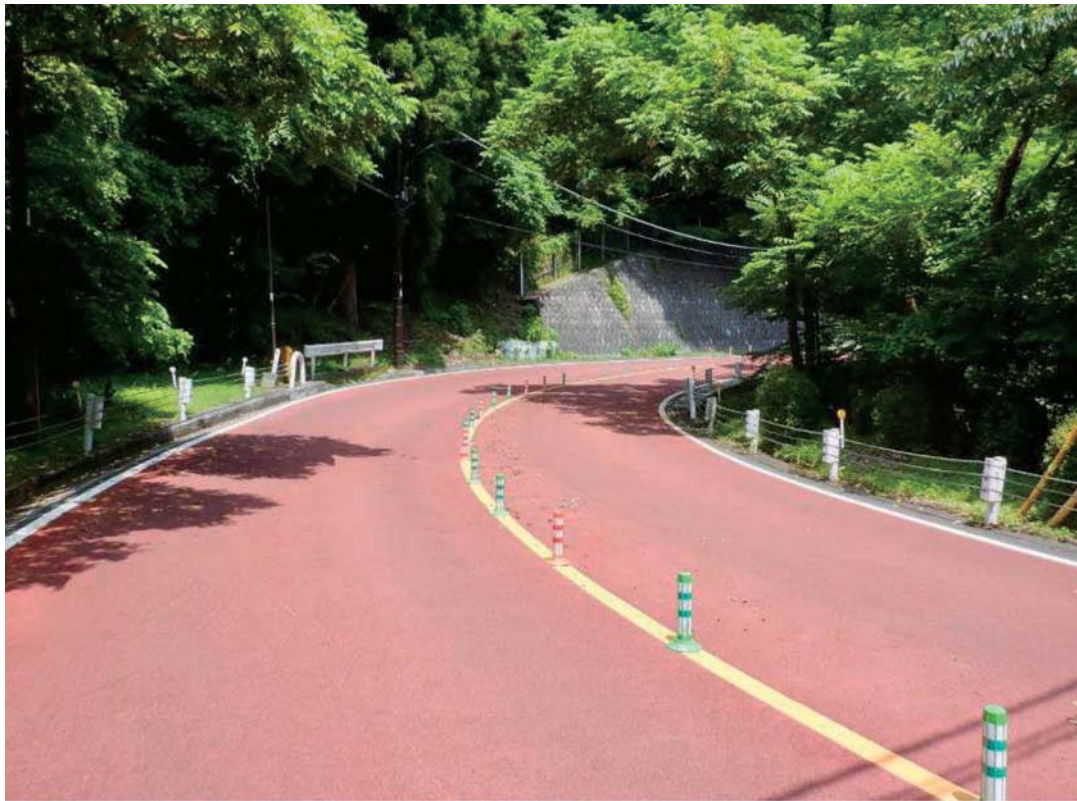
路面補修事業 「一般都道川野上川乗線（第 206 号）奥多摩周遊道路」 （西多摩郡奥多摩町川野地内） 令和 6 年 7 月完成
