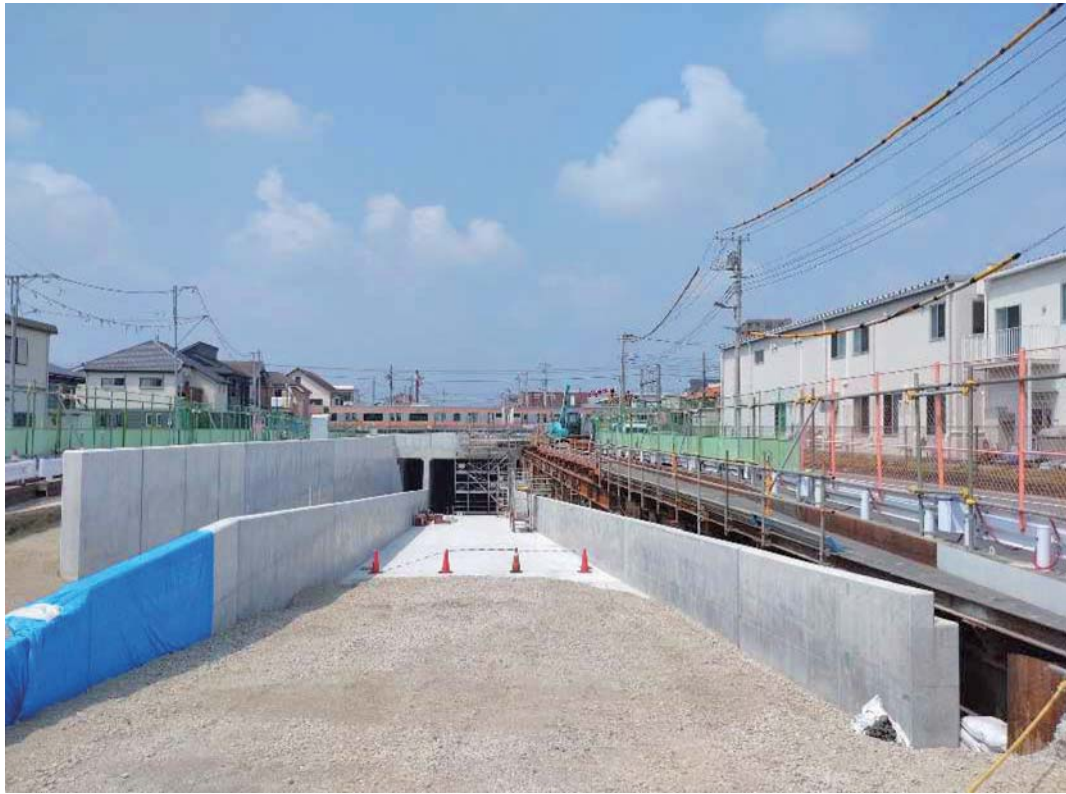
道路整備事業 「志茂立体交差事業」 一般都道瑞穂あきる野八王子線(第166号) 福生市志茂地内から福生地内 令和7年7月
