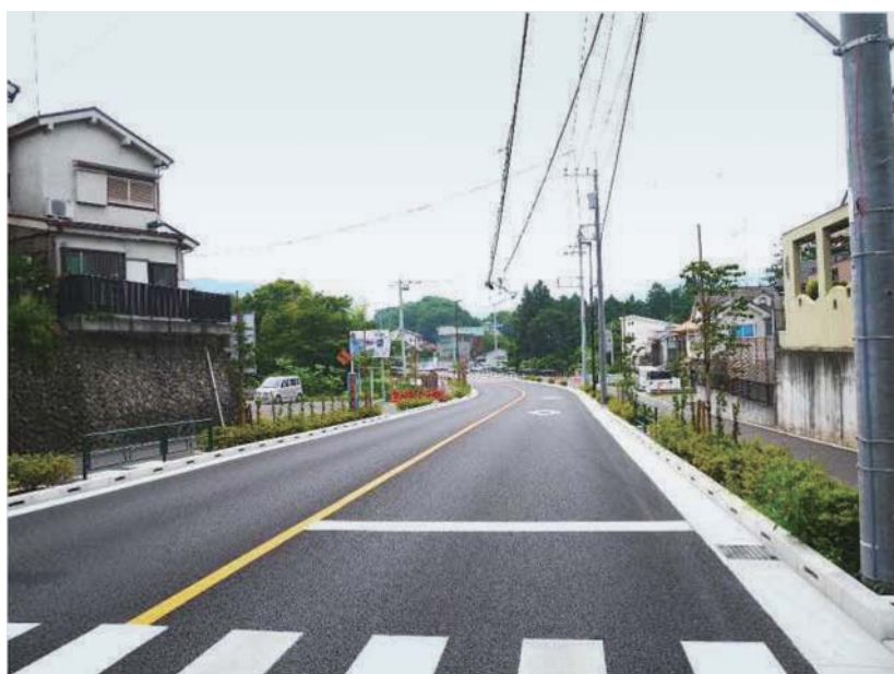
整備が完了した凱旋橋付近
