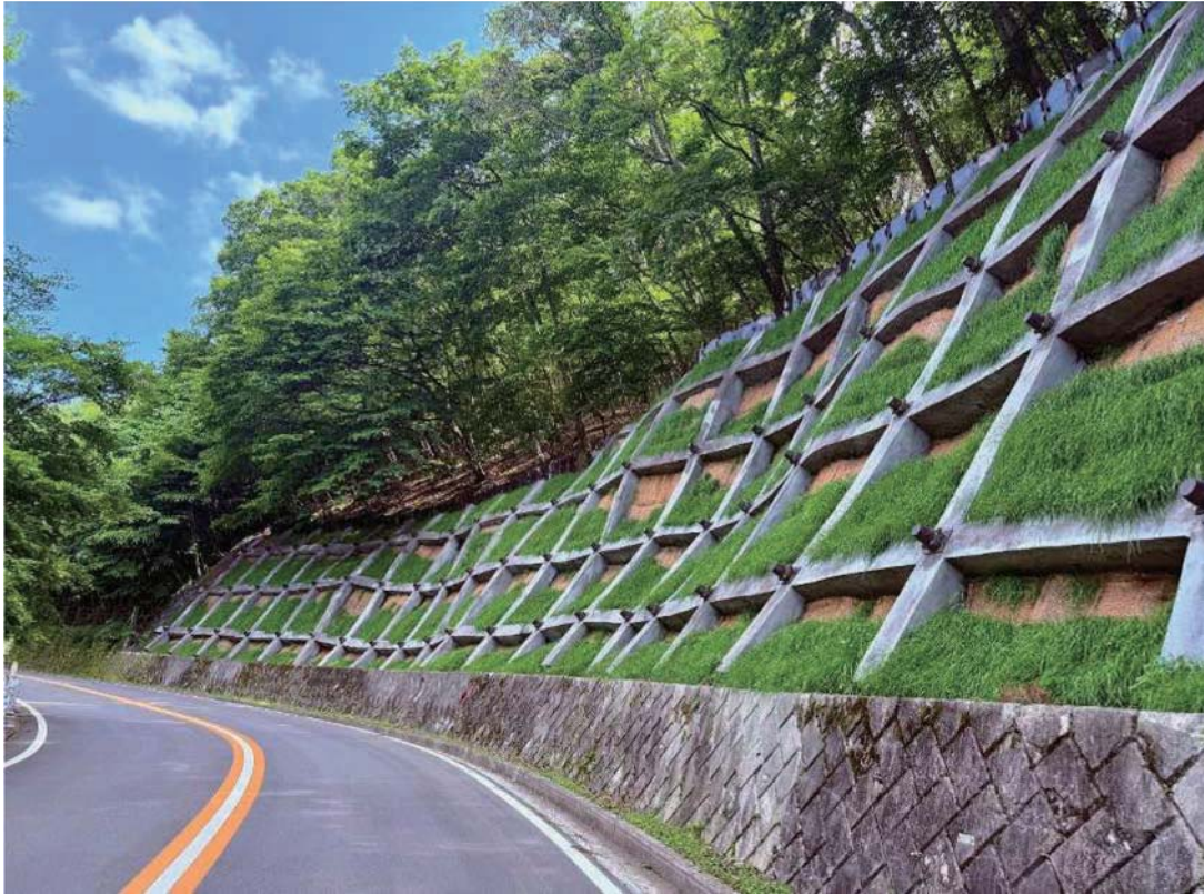
道路災害防除事業（一 206-54 上斜面） 「一般都道川野上川乗線（第 206 号）奥多摩周遊道路」 （西多摩郡奥多摩町川野地内） 令和 7 年 2 月完成
