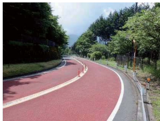
交通安全施設事業（すべり止め舗装） 「奥多摩周遊道路 9.3 km 付近」 令和 6 年 10 月完成
