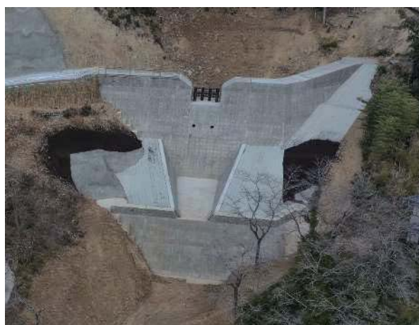
本宿地区第一沢(えん堤)
