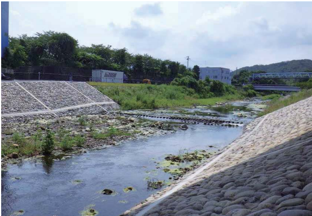
中小河川整備事業 「平井川整備工事」 （あきる野市菅生地内） 令和7年6月
