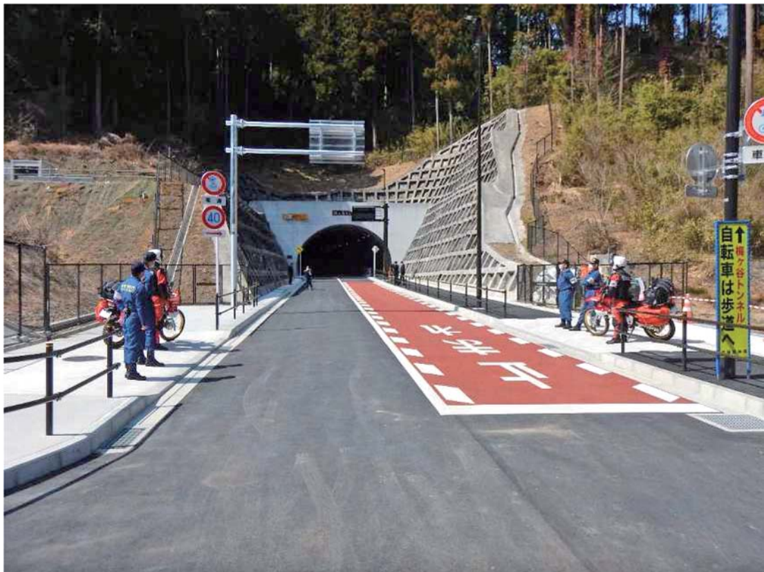
うめがた 梅ヶ谷トンネル
