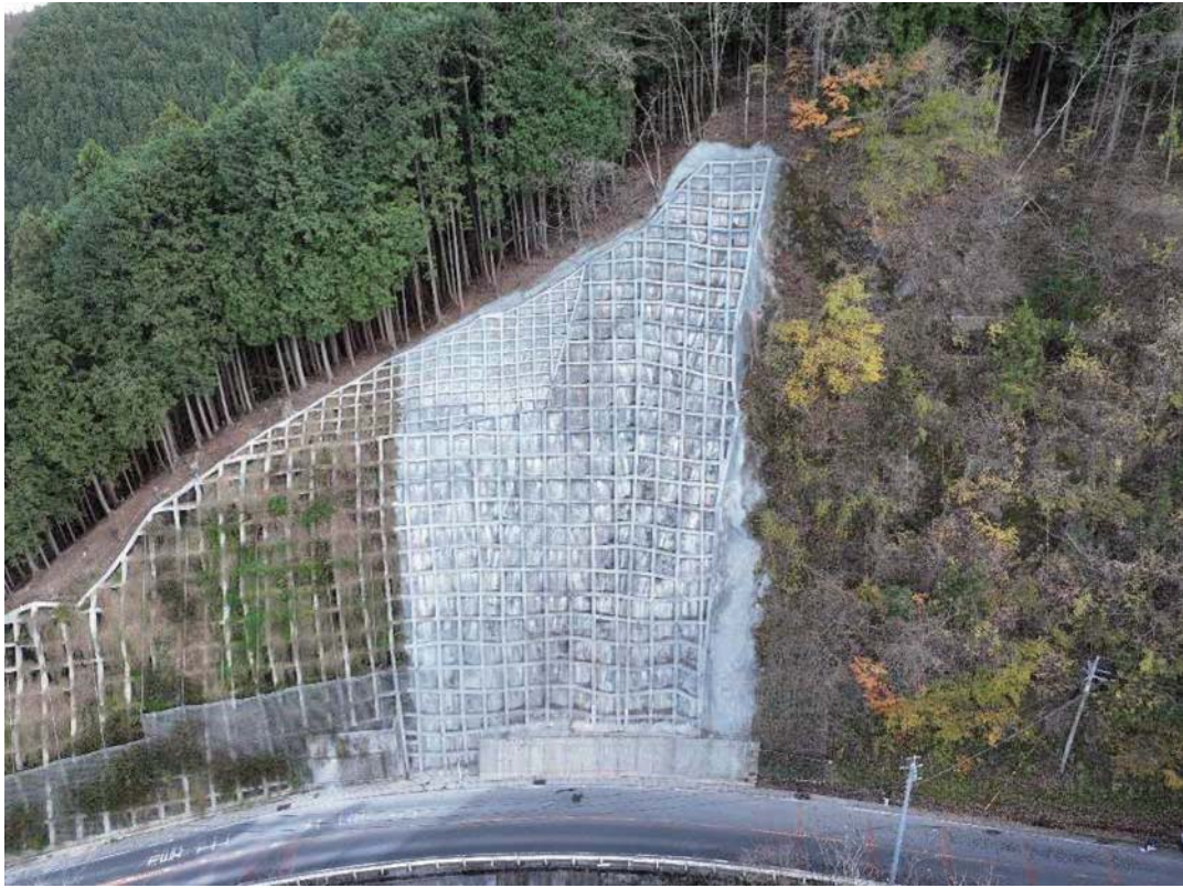
道路災害防除事業（主 33-123 上斜面） 「主要地方道上野原あきる野線（第 33 号）」 西多摩郡檜原村南郷地内 令和 7 年 2 月完成
