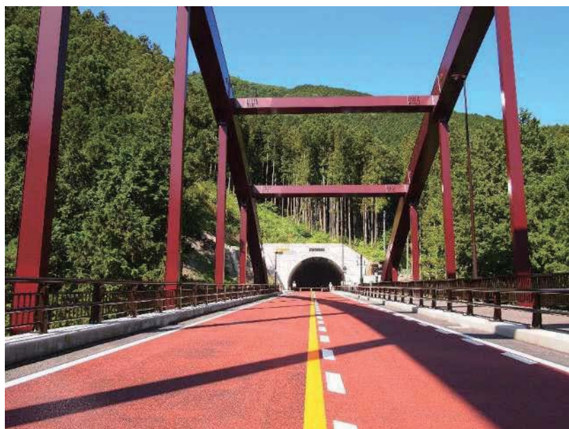
将門大橋と城山トンネル坑口
