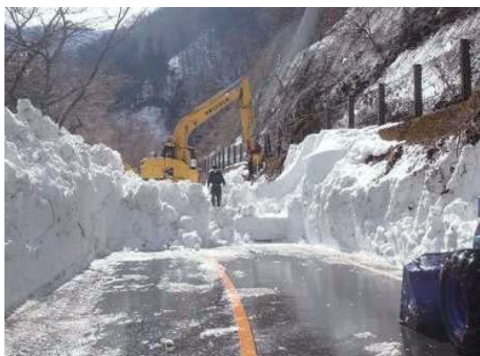
豪雪時の除雪作業 「奥多摩周遊道路」 平成26年3月撮影
