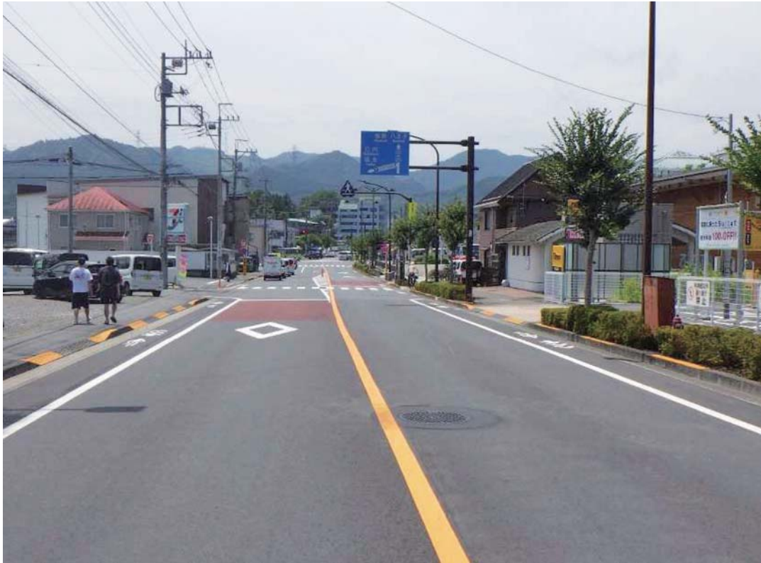
路面補修事業及び交通安全施設事業（すべり止め舗装） 「主要地方道青梅あきる野線（第 31 号）秋川街道」 あきる野市館谷地内 令和 7 年 5 月完成
