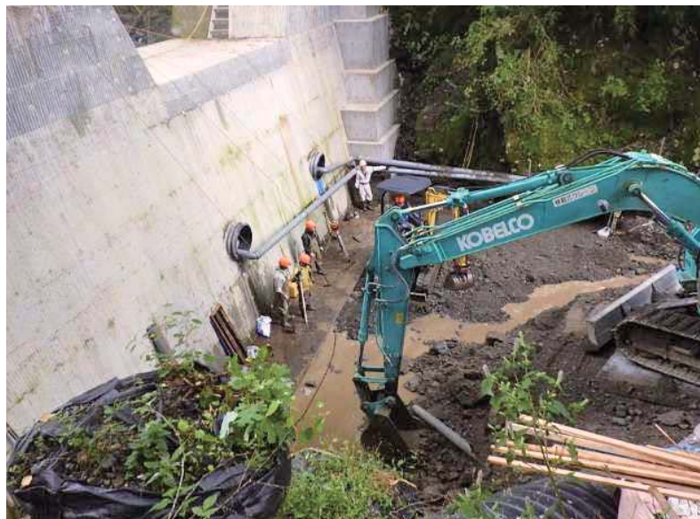
大丹波川砂防施設防災工事(5号堰堤)
