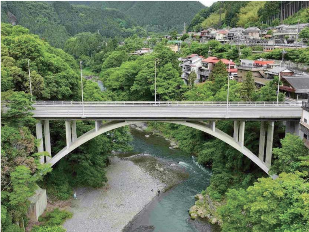
橋梁長寿命化事業（御岳橋長寿命化） 「一般都道十里木御嶽停車場線（第 201 号）」 青梅市御岳一丁目から御岳本町地内 令和 7 年 6 月完成
