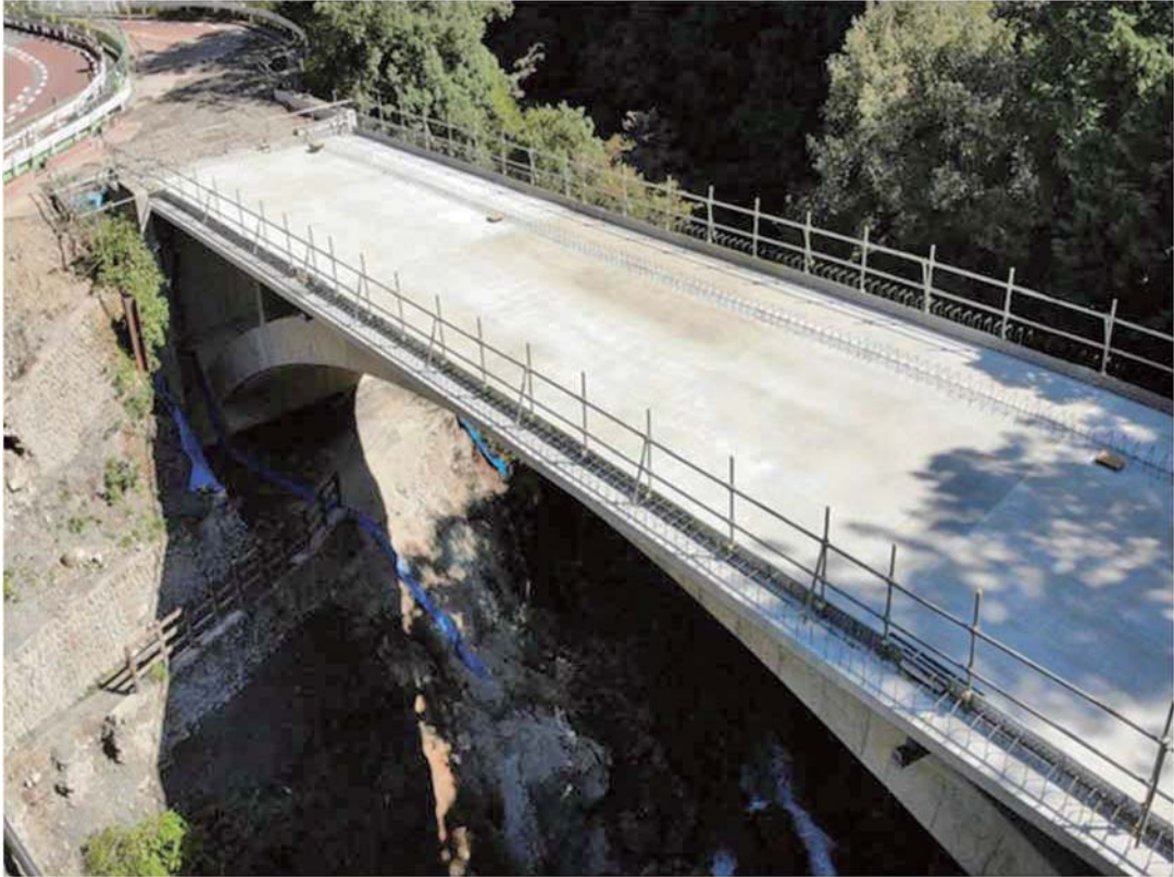
橋梁整備事業 「本宿4号橋（仮称）製作架設工事」 （檜原村本宿地内） 令和3年11月
