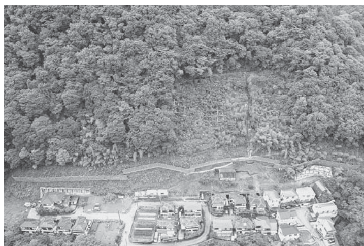
高尾 急傾斜地崩壊防止工事（八王子市高尾町地内）施工状況
