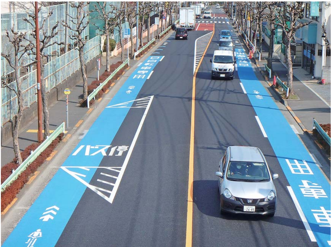
主要地方道 八王子武蔵村山線（主59号）多摩大橋通り 八王子市石川町
