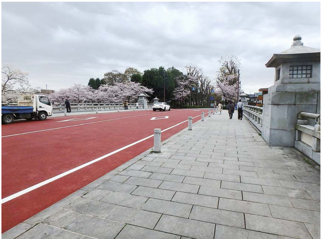
一般都道 多摩御陵線（一187号） 《南浅川橋》
