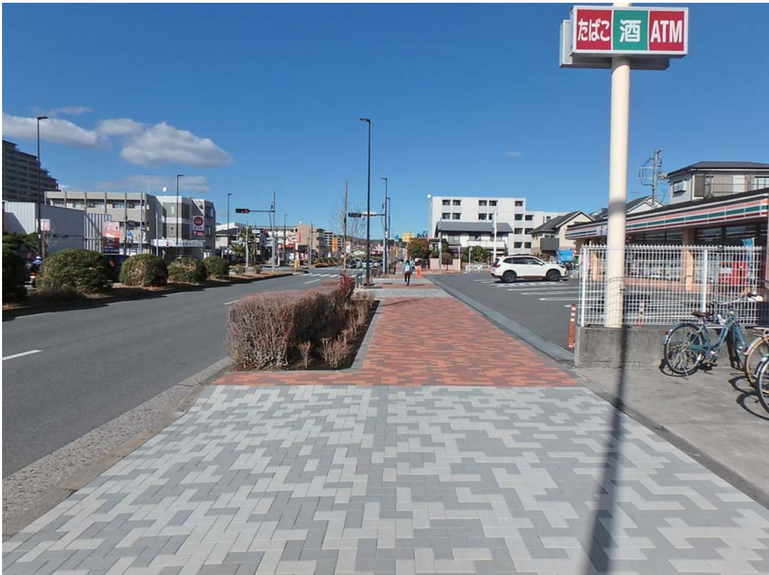
一般都道 小山乞田線（一158号）多摩ニュータウン通り 八王子市南大沢1～松木
