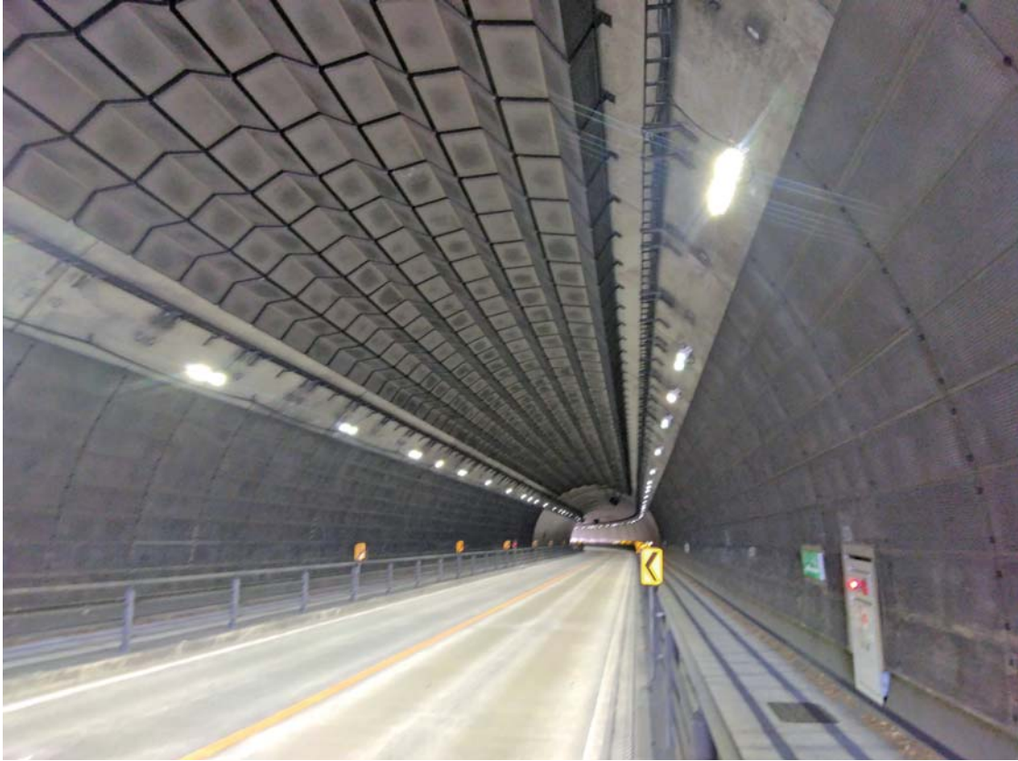
一般都道 町田平山八王子線（一155号）平山通り 《堀之内第三トンネル》
