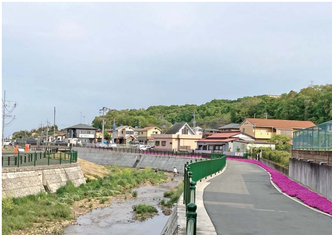
谷地川（八王子市加住町二丁目地内 城山下橋上流）
