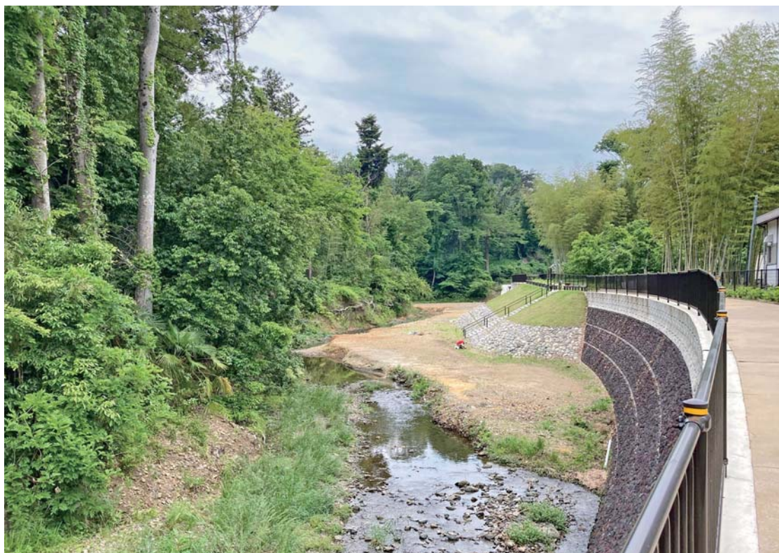
城山川（八王子市元八王子町二丁目地内 出羽橋上流）
