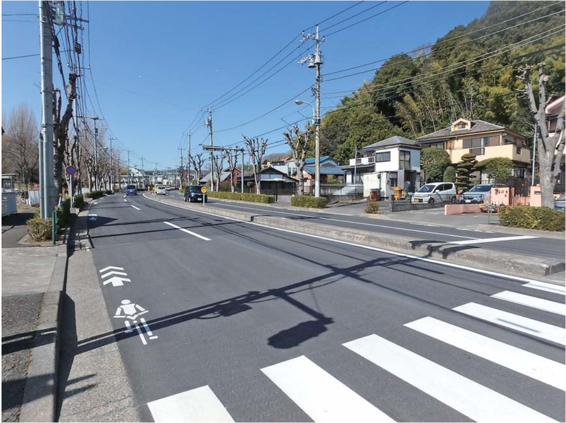
主要地方道 府中相模原線（主20号） 八王子市鎌水～鎌水2
