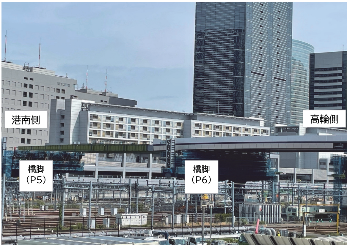
〔街路整備〕環状第4号線 鉄道区域施工状況(鉄道会社協定委託工事)上部工施工中
