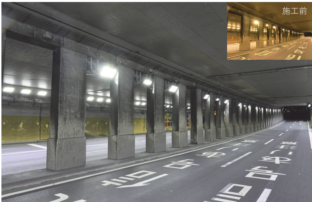
[照明設備改修工事(LED化)] 宝町地下自動車道
