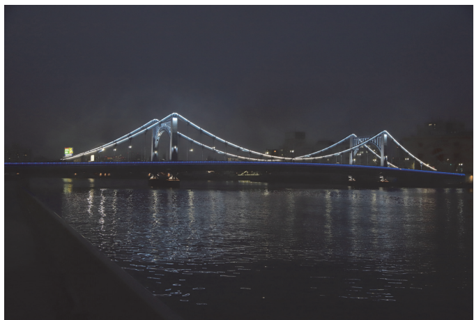
[長寿命化工事 (塗装)] [景観照明工事] 清洲橋
