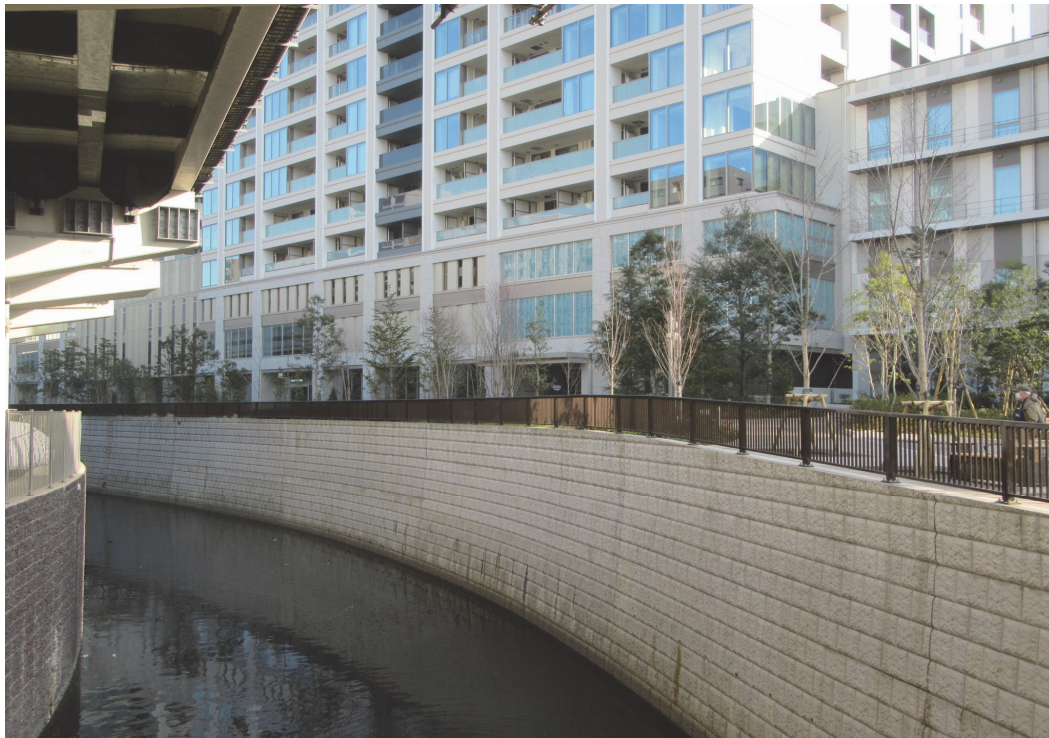
〔河川整備〕 古川護岸整備 新古川橋下流付近
