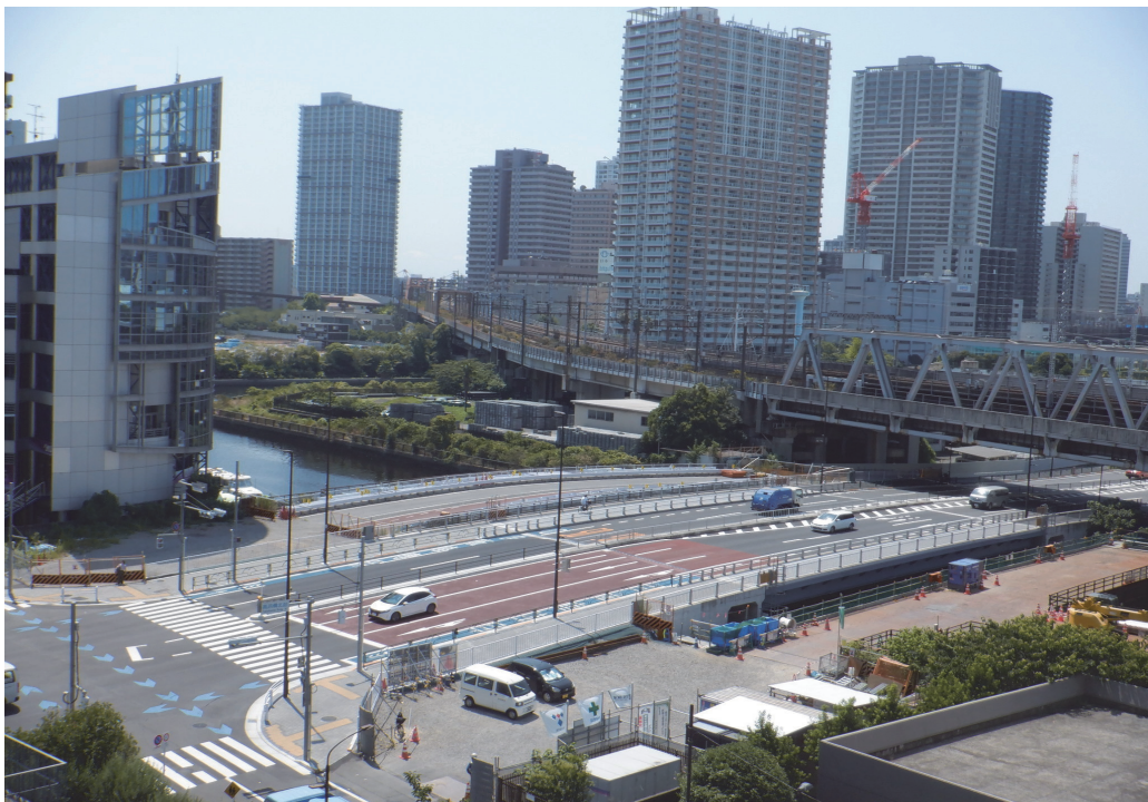
〔橋梁整備〕 高浜橋 四車線切替
