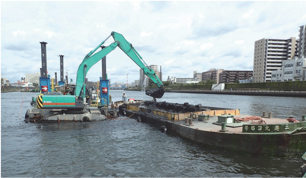
[河川しゅんせつ] 隅田川 尾久橋下流付近
