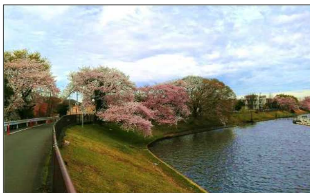
新大場川水門上流【現況】
