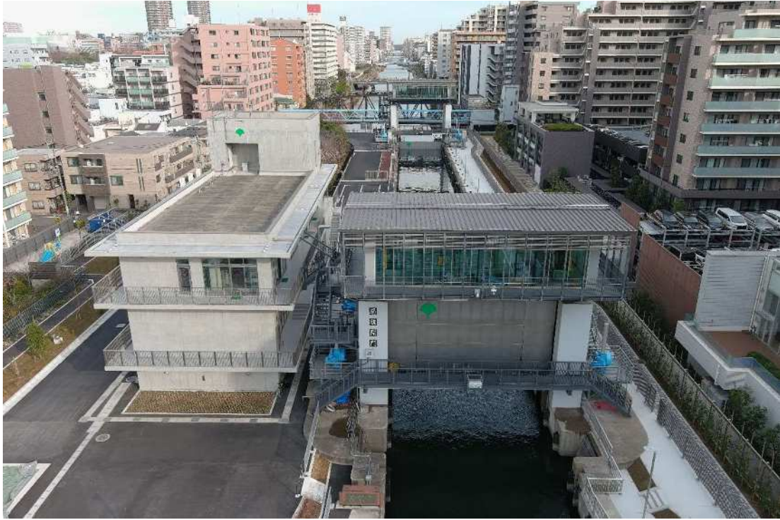
扇橋閘門 耐震・耐水対策の整備：江東区猿江一丁目
