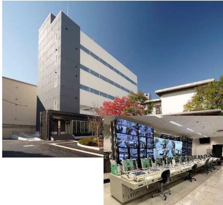
水門管理センター
