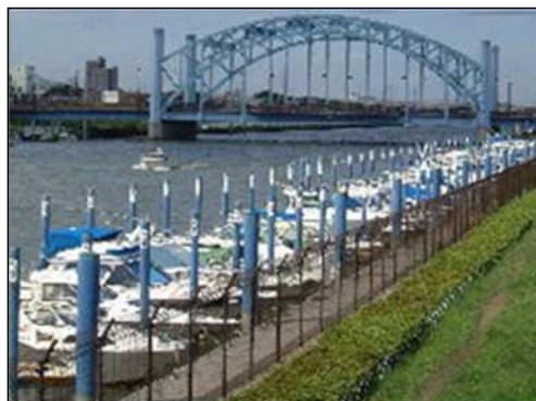
新中川【暫定係留施設整備後】
