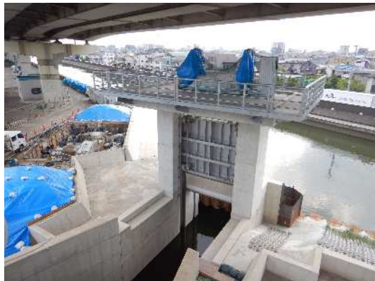
(施工状況：内水側)
