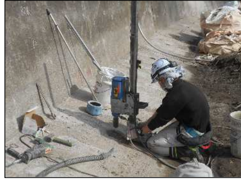
【せん断補強施工中】
