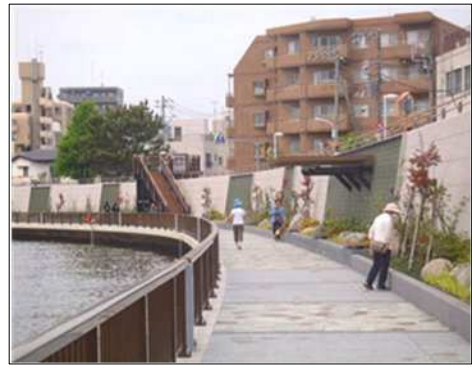
中川護岸（七曲区間）【施工後】
