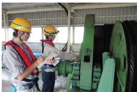
水門上屋設備点検
