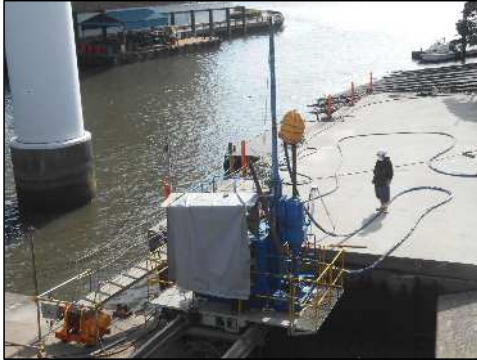
【地盤改良施工中】
