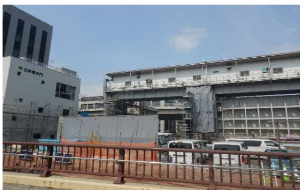
(施工状況：内水側)
