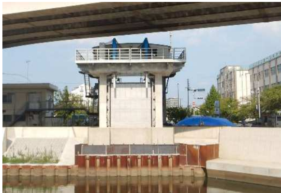
(施工状況：綾瀬川側)
