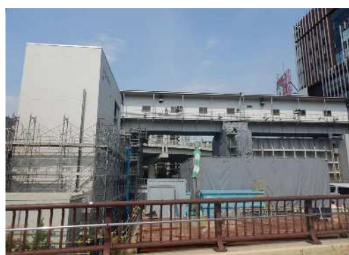
(施工状況：管理棟)
