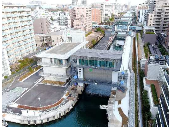
扇橋閘門の全景
