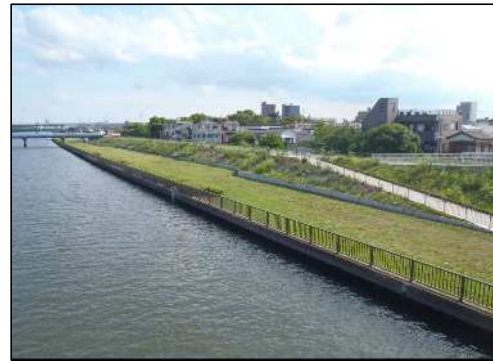
低水護岸・高水敷整備【施工後】
