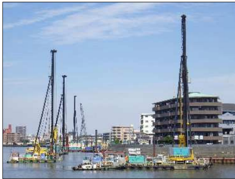
護岸耐震補強工事【地盤改良施工中】
