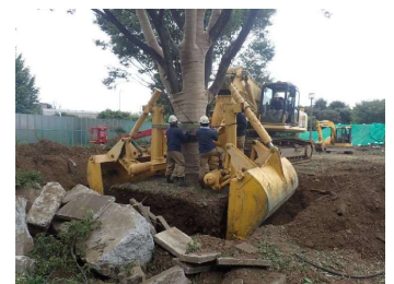
②移植機の侵入、根鉢をしっかりとつかみます。
