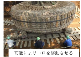
ミチイタ、コロ、コンタ、カンザシ、滑車、ワイヤー等の設置
