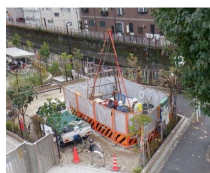
ボーリングにより観測井戸の設置査
