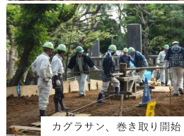
ミチイタ、コロ、コンタ、カンザシ、滑車、ワイヤー等の設置
