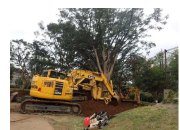
④あらかじめ掘削しておいた植穴におろし、傾きなどを調整
