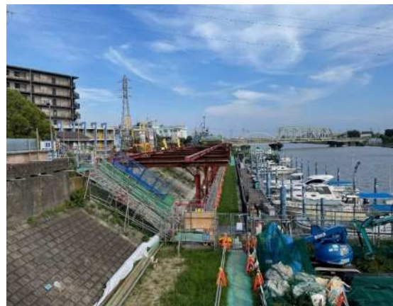
【高圧線直下での地盤改良状況】
