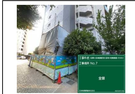
【地質調査（ボーリング調査）】
