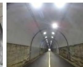
補強部材による内面の補強
