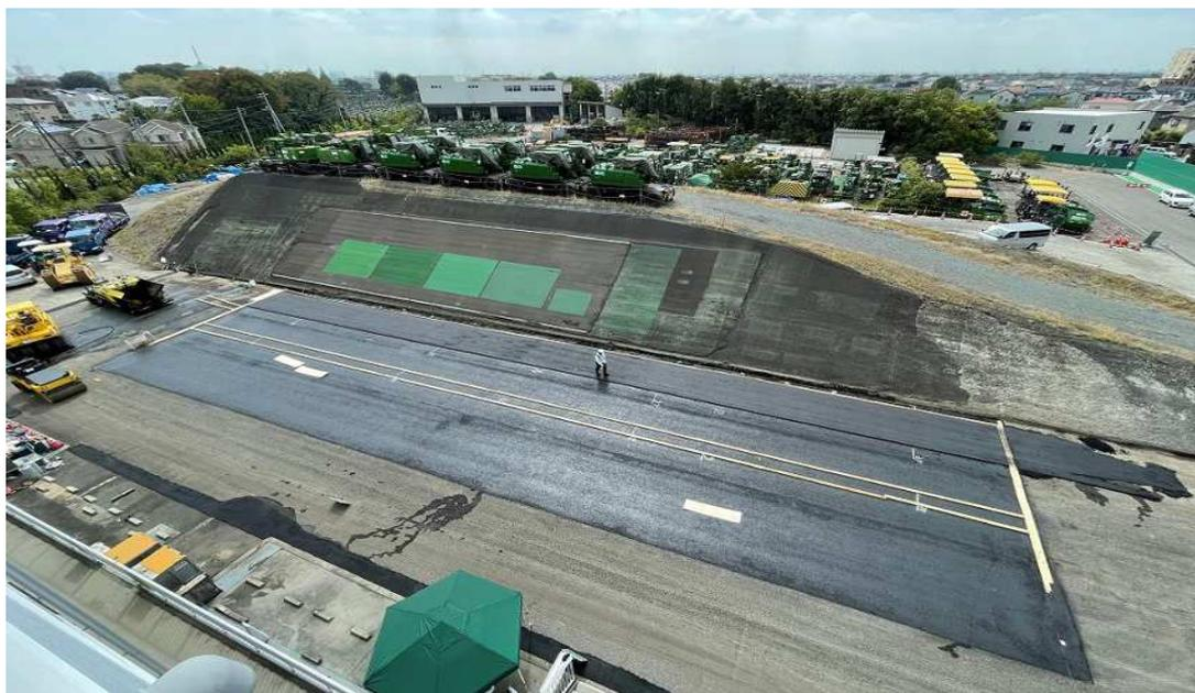
【低炭素（中温化）アスファルト 場内試験施工】
