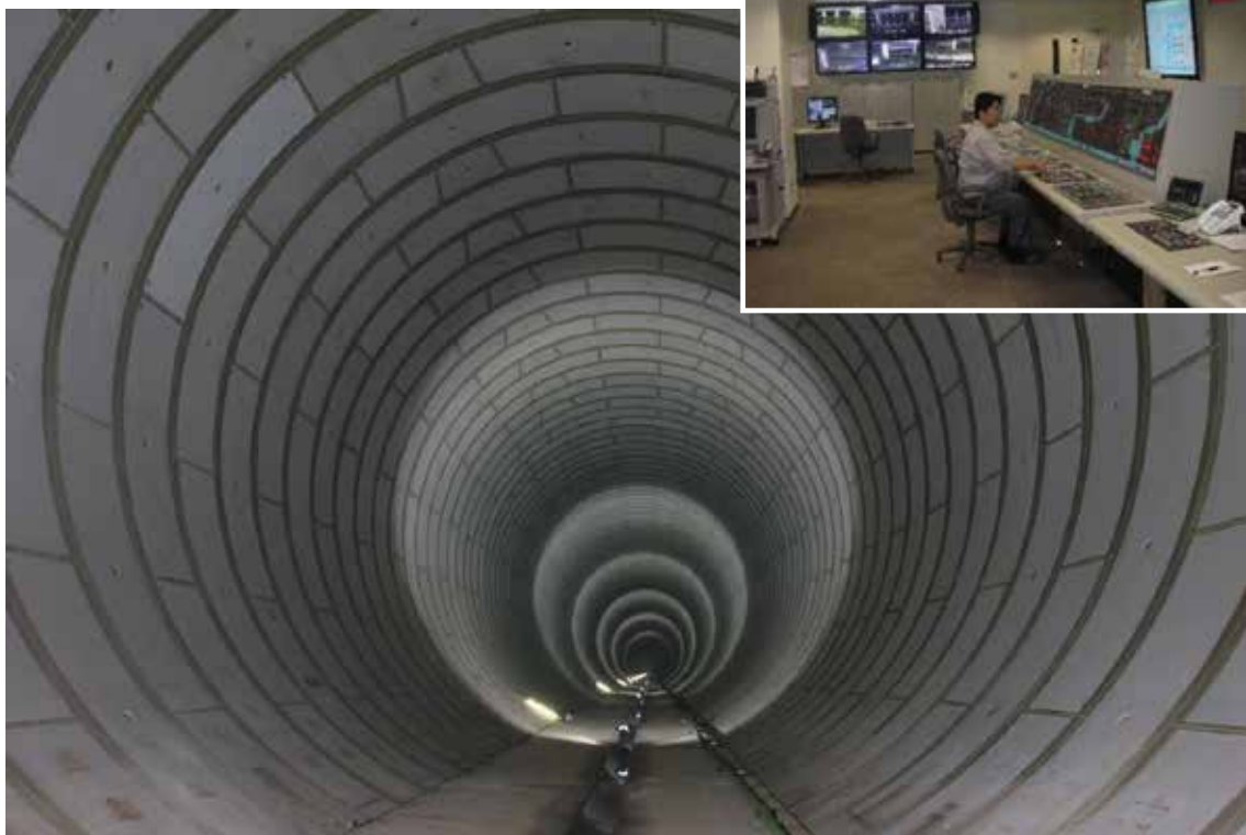
神田川・環状七号線地下調節池(稼働中) 本体トンネルと遠方監視操作システム 神田川、善福寺川および妙正寺川の3河川から洪水を取水して、このトンネル内に貯留します。 各河川の水位監視や取水の際のゲート操作等は、善福寺川取水施設の監視室で行います。
