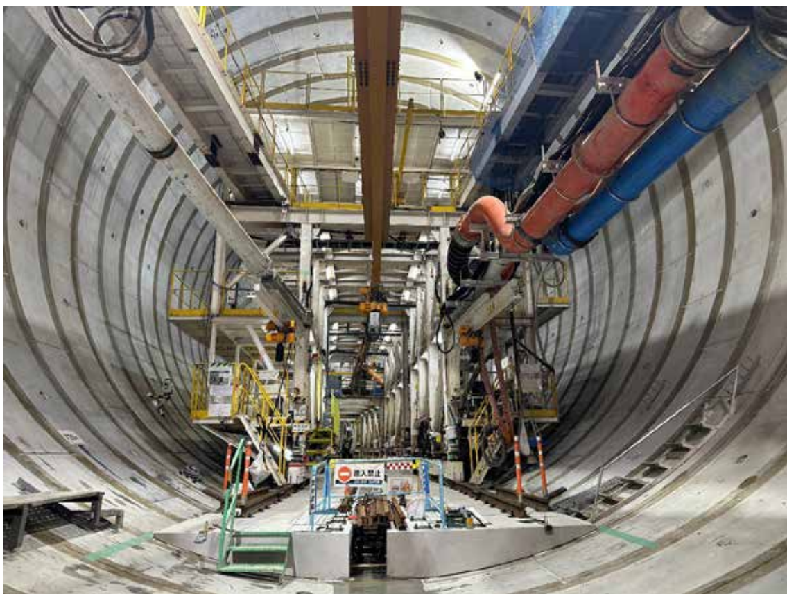
環状七号線地下広域調節池(石神井川区間)工事〔中野区野方から練馬区高松地内〕 妙正寺川立坑からシールドマシンが発進し、環状七号線の地下でトンネル掘進を進めています。
