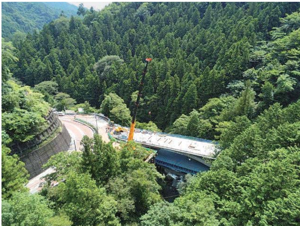
4号橋(RCアーチ橋)架設工事状況
