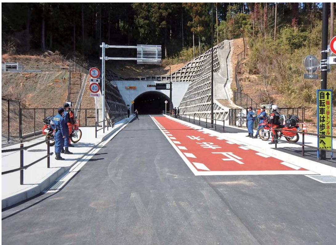
道路整備事業「梅ヶ谷トンネル整備工事」 一般都道大久野青梅線（第238号） 西多摩郡日の出町大久野地内から青梅市梅郷一丁目地内まで
