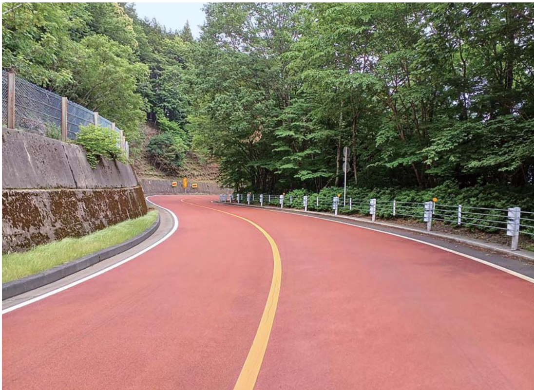
路面補修事業 「一般都道川野上川乗線（第206号）奥多摩周遊道路」 （西多摩郡檜原村藤原地内） 令和5年6月完成
