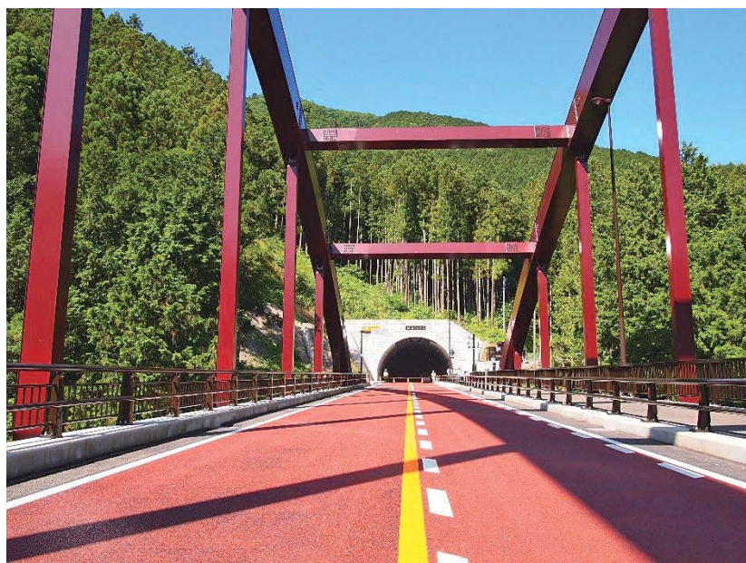
(将門大橋と城山トンネル坑口)
