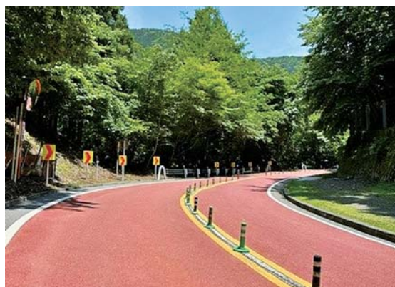
交通安全施設事業（すべり止め舗装） 「奥多摩周遊道路 7.1 km 付近」 令和 5 年 11 月完成
