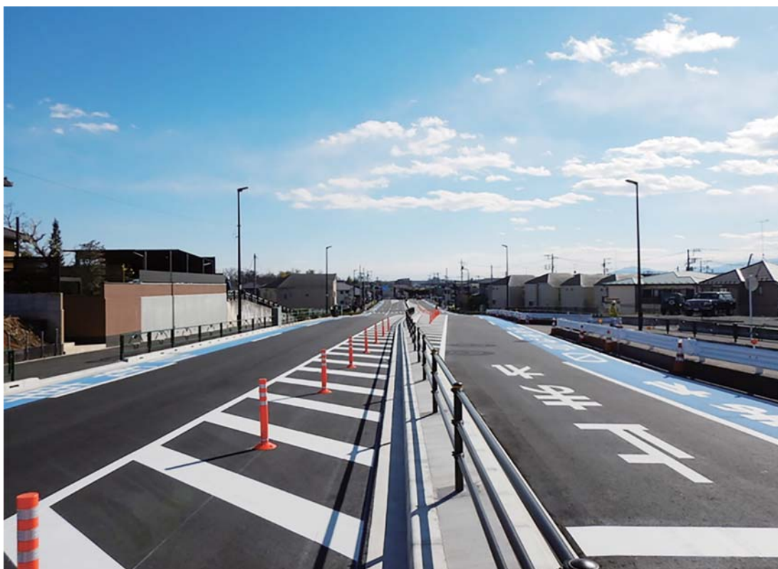
街路整備設業「街路築造工事及び電線共同溝設置工事（3西一福生3・3・30）」 福生都市計画道路3・3・30号武蔵野工業線 福生市大字福生 令和5年2月暫定開放
