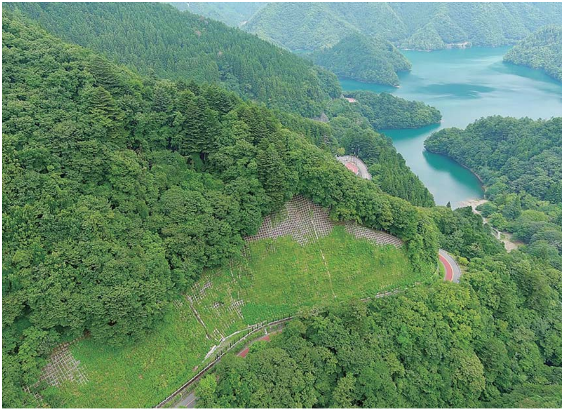
道路災害防除事業（一206-32～33上斜面） 「一般都道川野上川乗線（第206号）奥多摩周遊道路」 （西多摩郡奥多摩町川野地内） 令和6年2月完成
