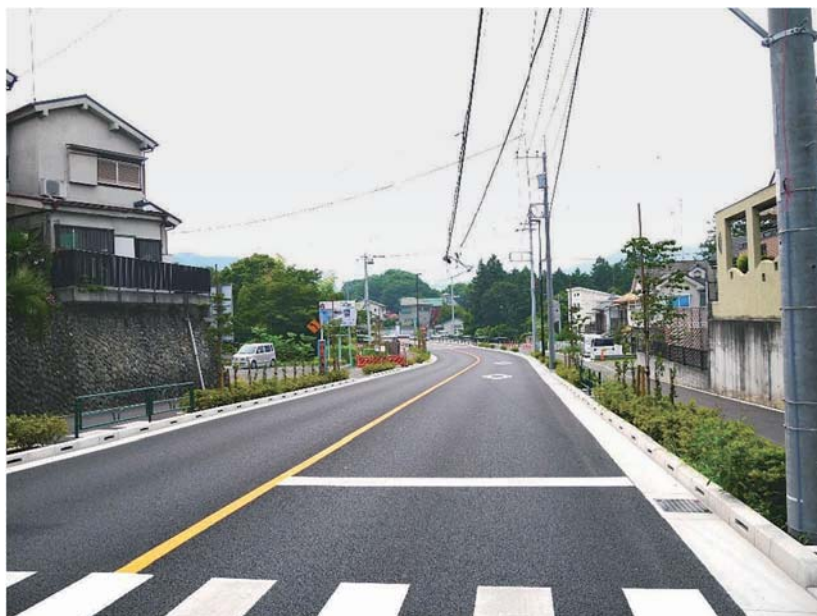
(整備が完了した凱旋橋付近)
