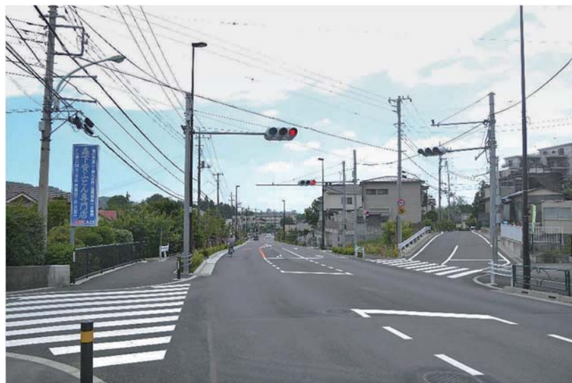
整備が完了したⅠ期区間
