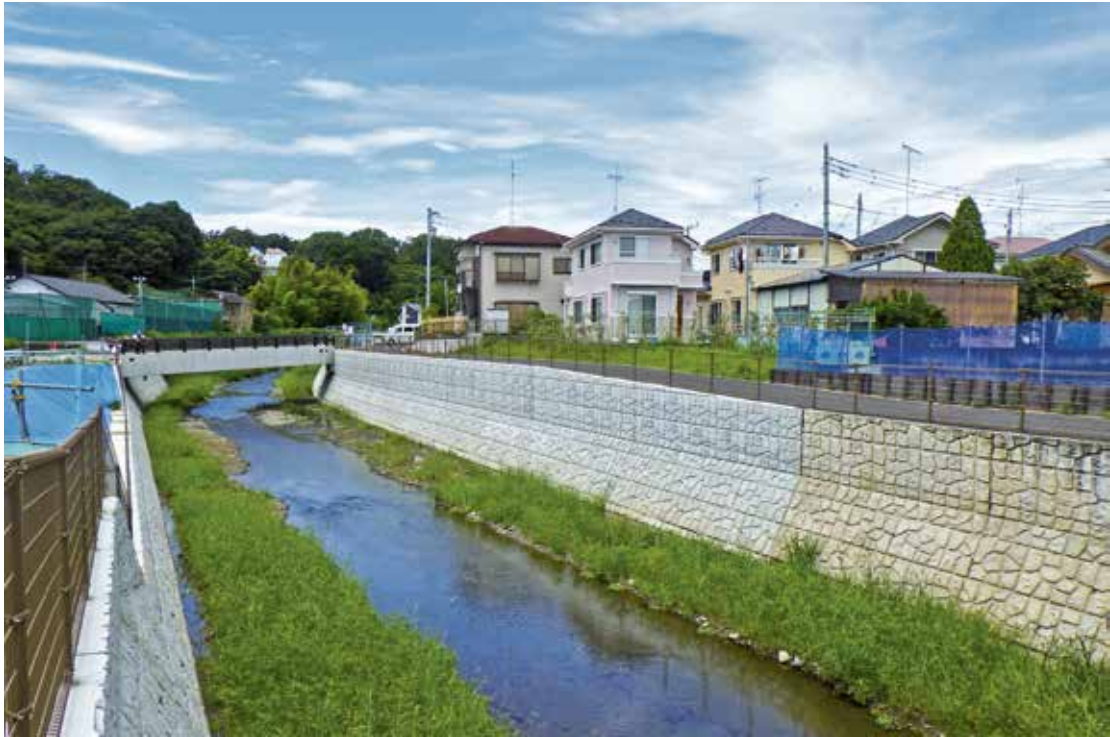
○鶴見川：宮川橋上流（町田市函師町） 1時間50mm降雨に対応できる護岸を整備
