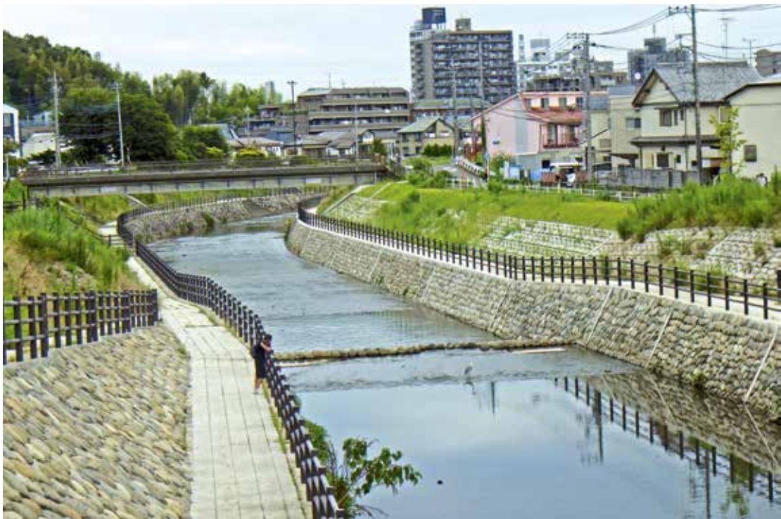
○大栗川：並木橋下流（多摩市和田） 環境に配慮した護岸の整備や遊歩道の設置により快適な水辺空間を創出
