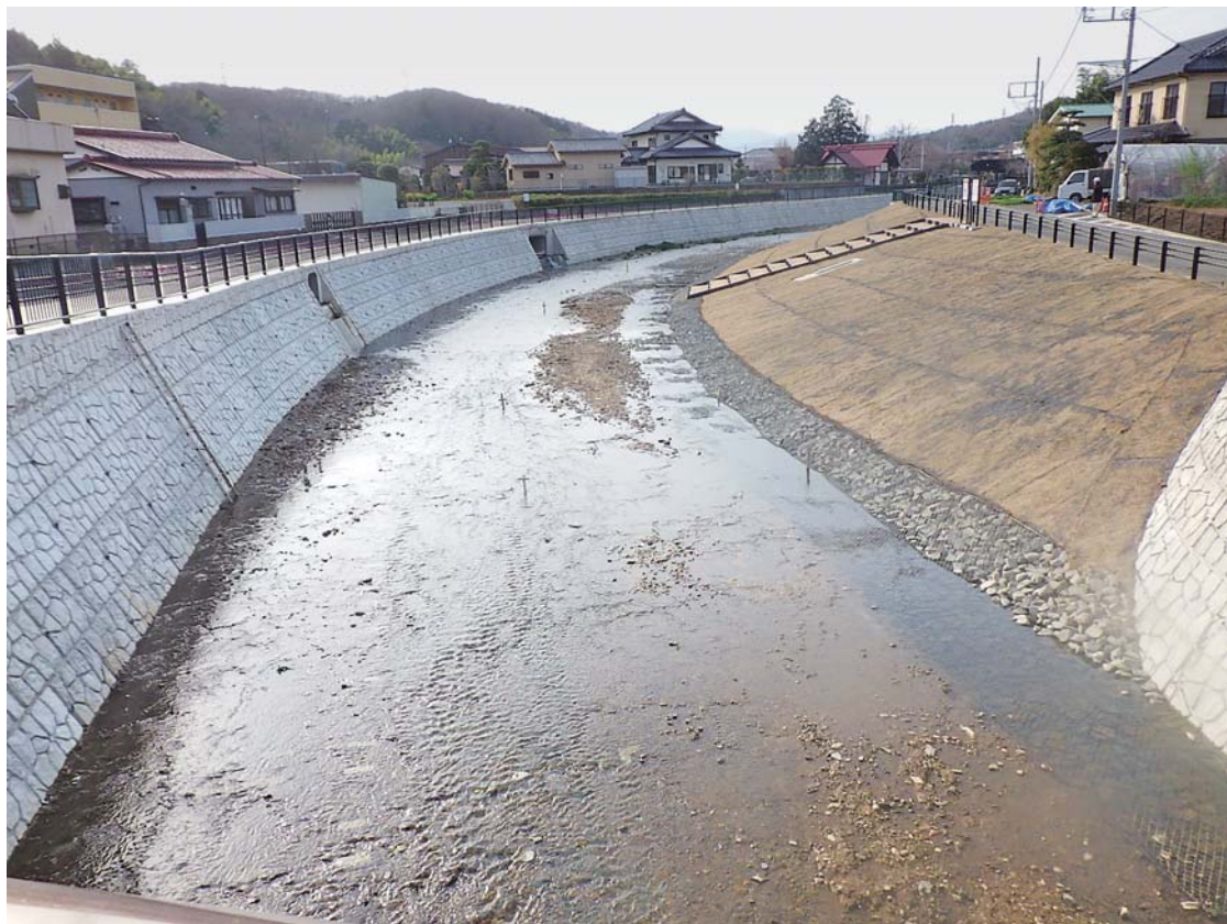
谷地川（八王子市加住町地内 城山下橋上流）
