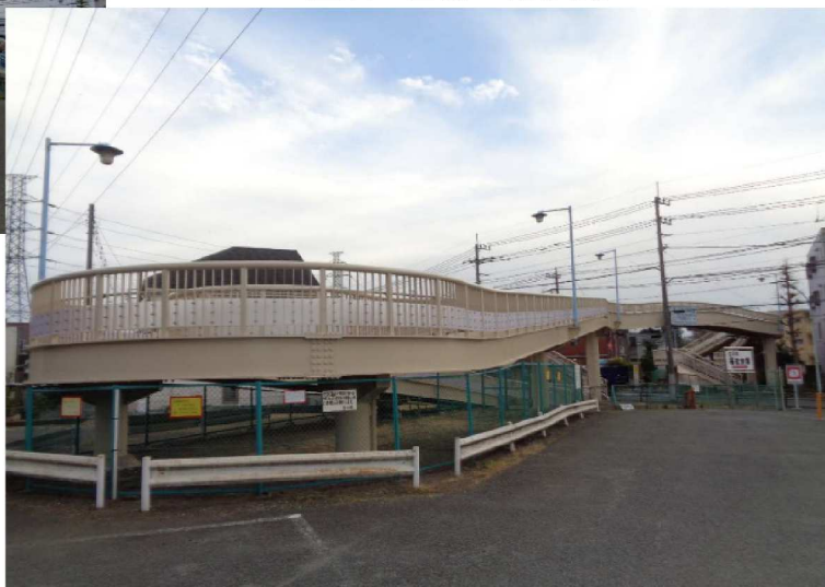
〔塗替え塗装: 補修後〕
