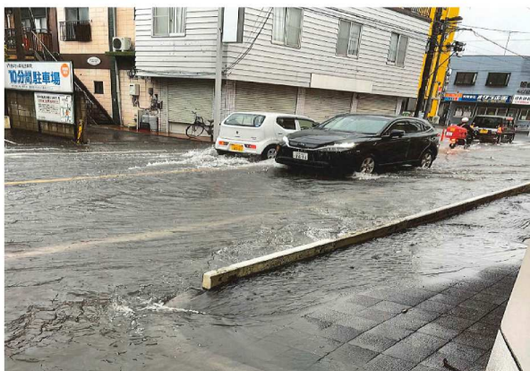
道路の冠水状況
