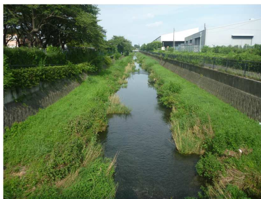
降馬橋下流付近（東久留米市）
