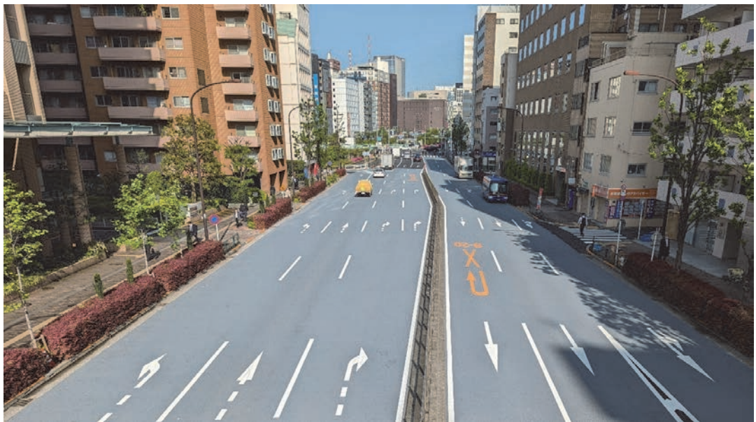
〔遮熱性舗装整備〕新富晴海線(中央区明石町付近)
