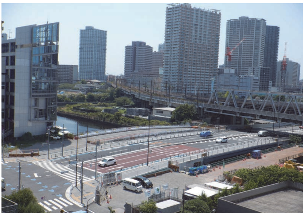
〔橋梁整備〕 高浜橋 四車線切替
