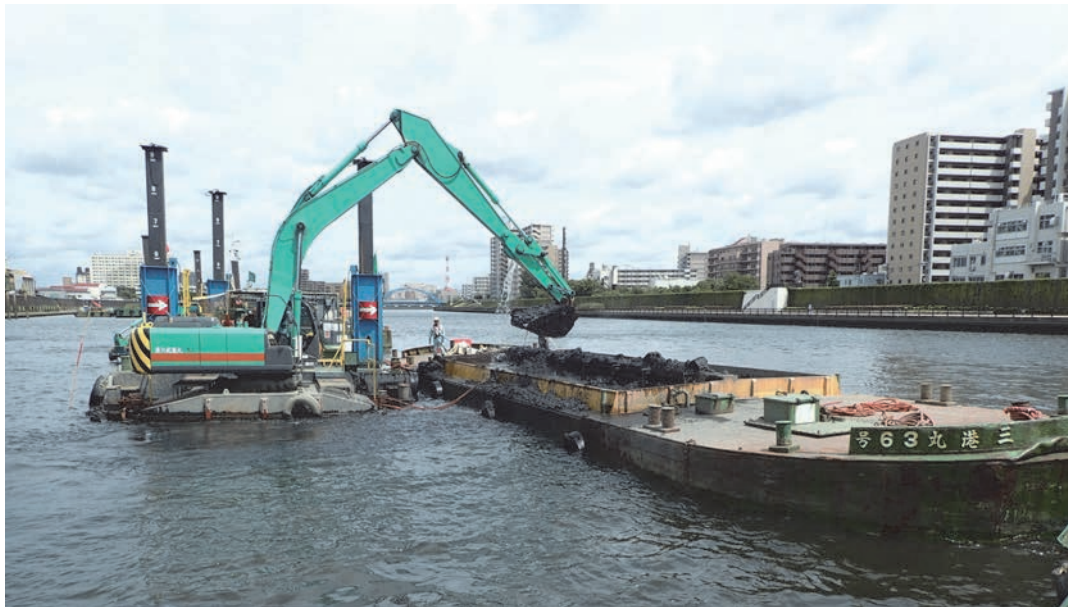
〔河川浚渫〕 隅田川 尾久橋下流付近
