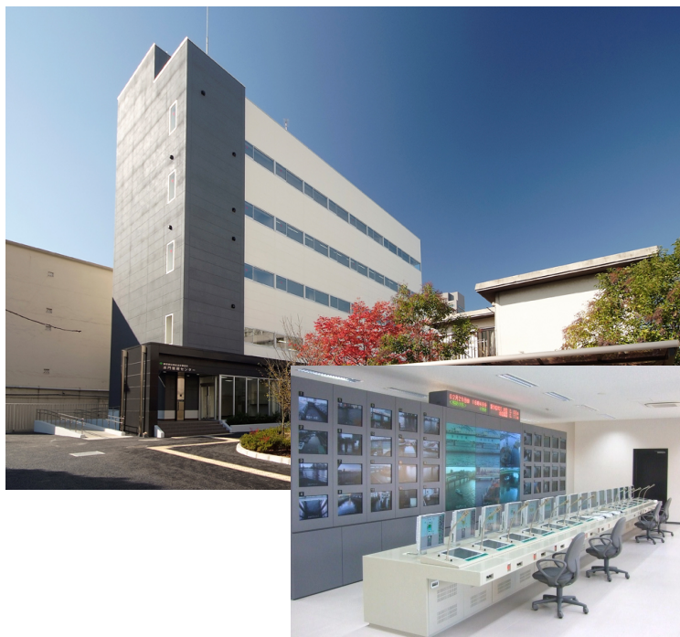
水門管理センター
