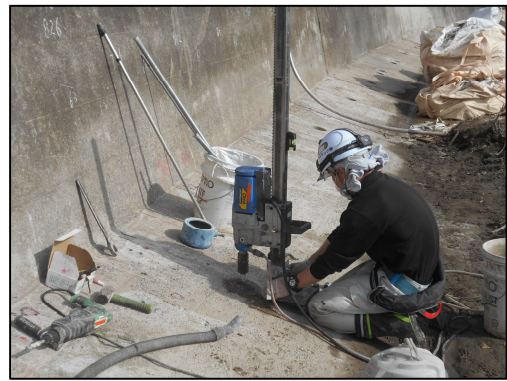
【せん断補強施工中】
