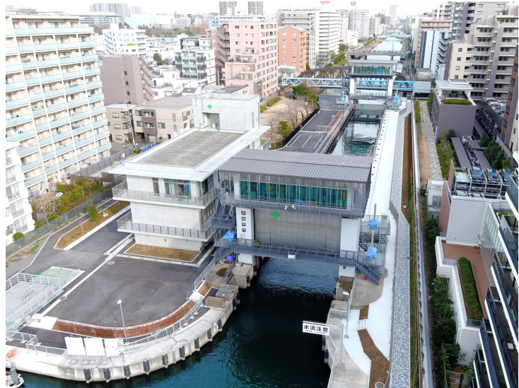
扇橋閘門の全景
