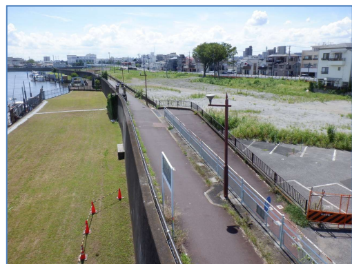
江戸川四丁目地区【施工前】
