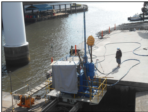
【地盤改良施工中】
