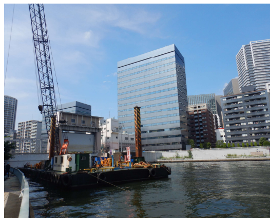
(施工状況：外水（隅田川）側)
