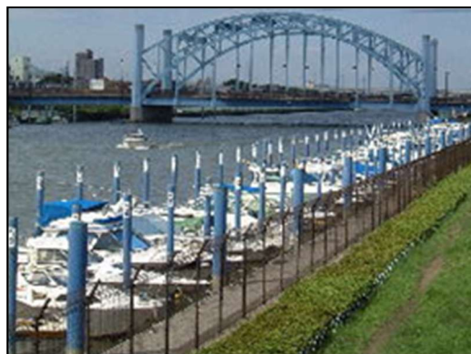
新中川【暫定係留施設整備後】
