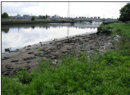
低水護岸整備【施工前】
