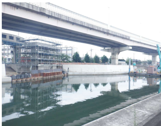
(施工状況：綾瀬川側)
