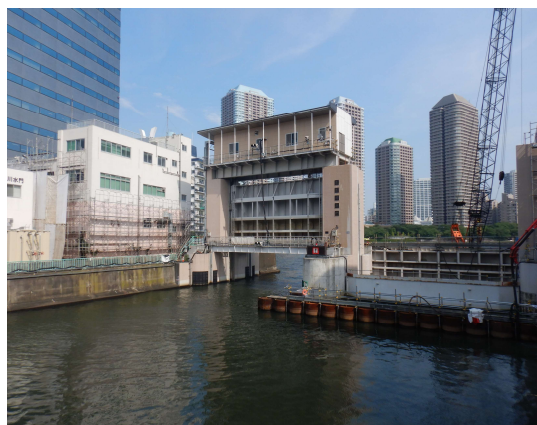
(施工状況：内水側)
