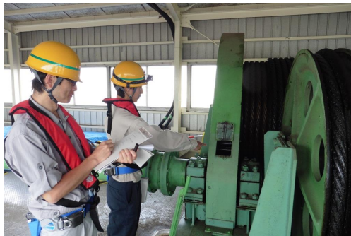
水門上屋設備点検
