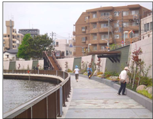
中川護岸（七曲区間）【施工後】
