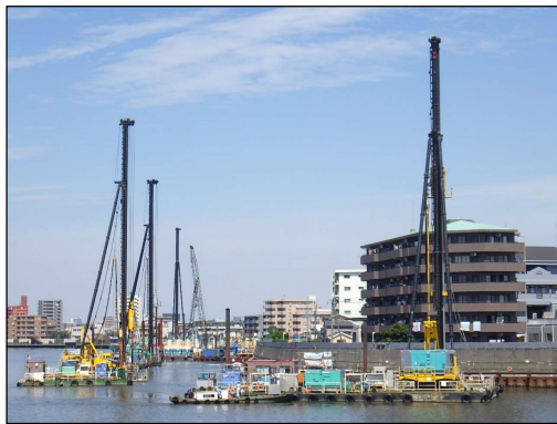
護岸耐震補強工事【地盤改良施工中】
