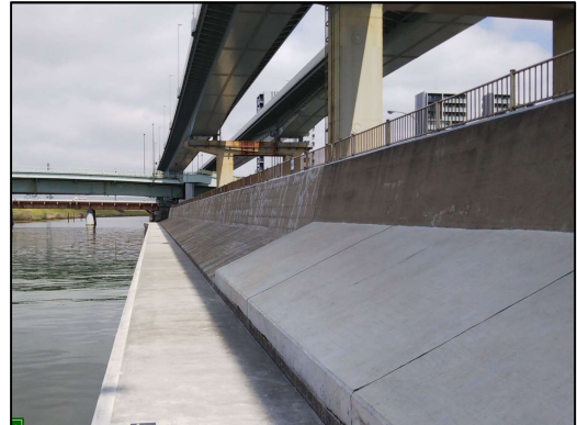
新四ツ木橋下流【施工後】
