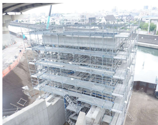
(施工状況：内水側)
