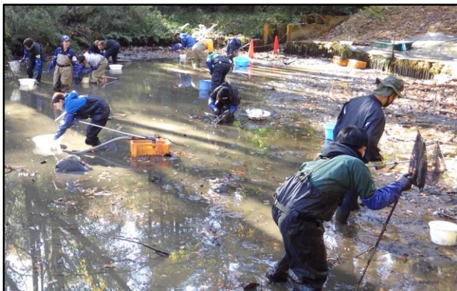
池の中での作業の様子（下池）
