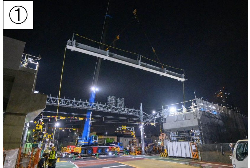
① 上り高架橋（踏切部） 桁架設状況（R4.4）
