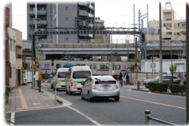
高架化工事中 (R6.10)
