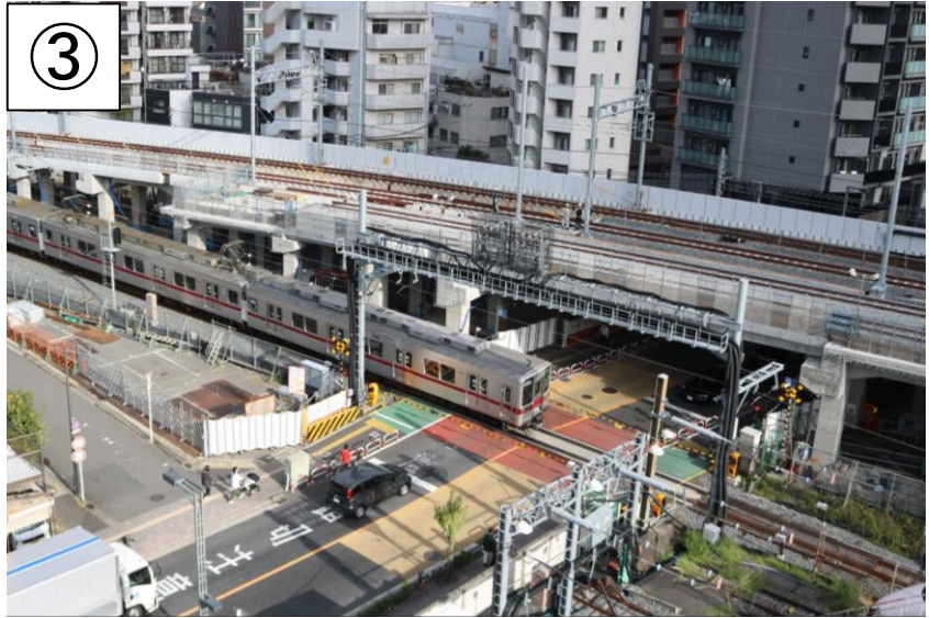
③ 下り高架橋 構築状況（R6.10）
