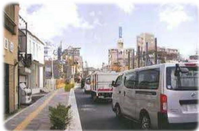
高架化工事着手前 (H29)
