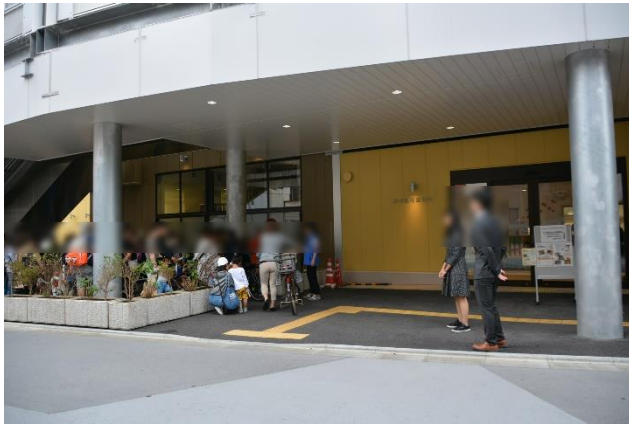
東向島児童館分館（外観）
