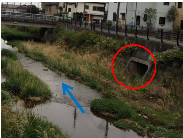
下水(雨水)排水管
