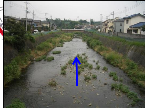
しもだ 下田橋上流側
