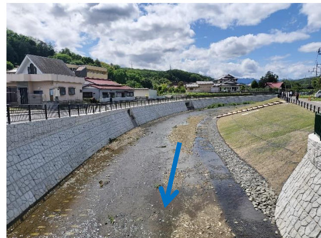
親水護岸整備(城山下橋上流)
