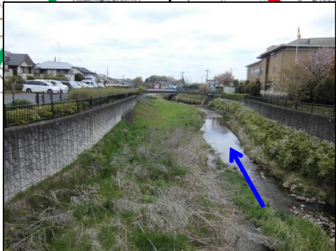
たきやま 滝山橋上流側
