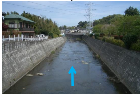
しょうじんば 精進場橋下流側
