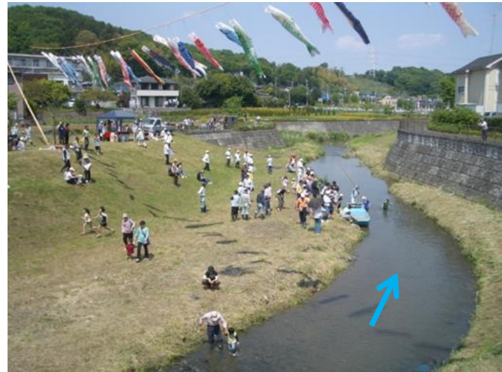
親水護岸整備(参道橋下流)
