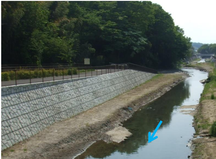
遊歩道整備(丸山橋上流)
