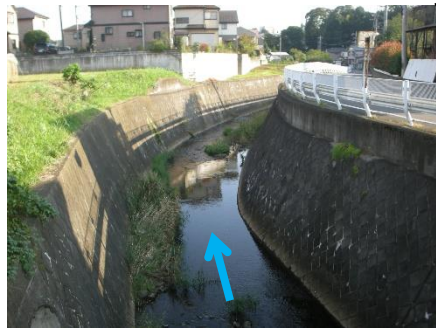
さかした 坂下橋下流側
