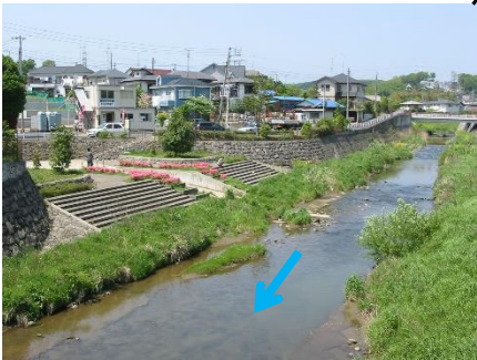
かすが 春日橋上流側
