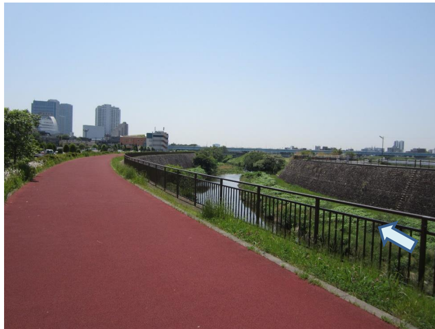
整備後の管理用通路(吉澤橋下流左岸)
