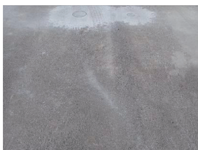
写真-7 舗装撤去の路面状況（試験施工後）
