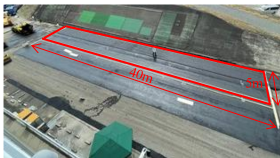
写真-1 場内試験路面施工状況
