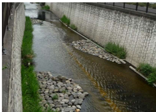
写真 4－2 自然環境に配慮した河床整備例（道々橋付近）
