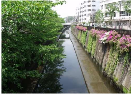
写真 4－1 護岸の緑化整備例（日蓮橋付近）
