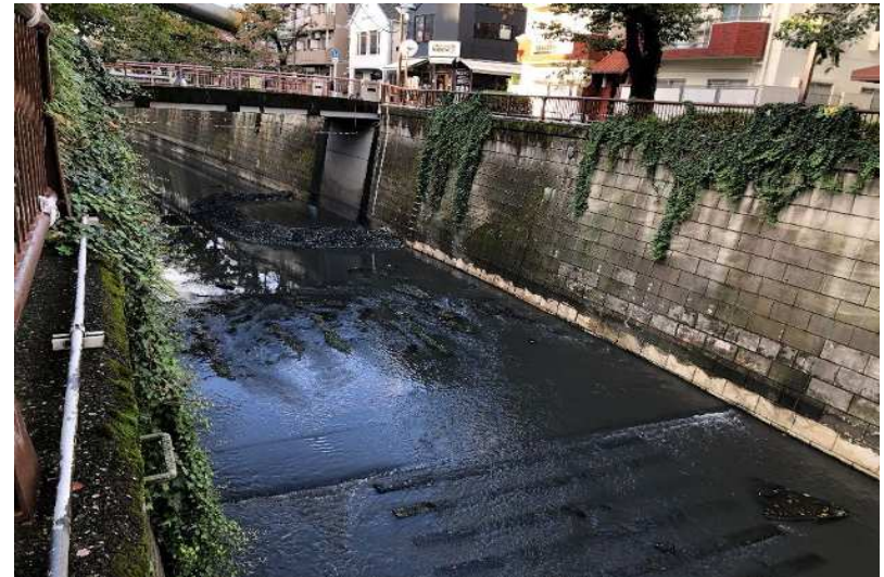
② 天神橋から下流側に向けて撮影
