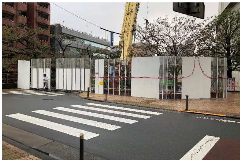
③作業基地 下流側より撮影
